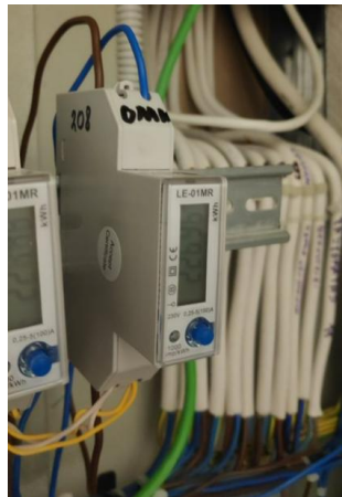
pav. 1 1F pakeistas elektros skaitiklis
