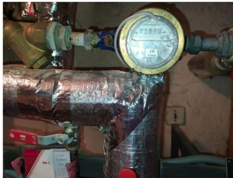
pav. 8 VS1.3 Sumontuota papildoma įranga ant esamo skaitiklio
