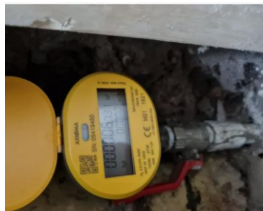
pav. 6 VS2.1 Pakeisto vandens skaitiklio vizualizacija
