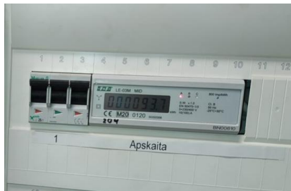
pav. 4 3F pakeistas elektros skaitiklis
