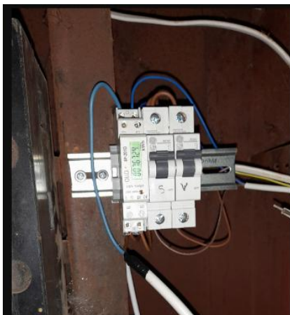
pav. 2 1F esamas elektros skaitiklis
