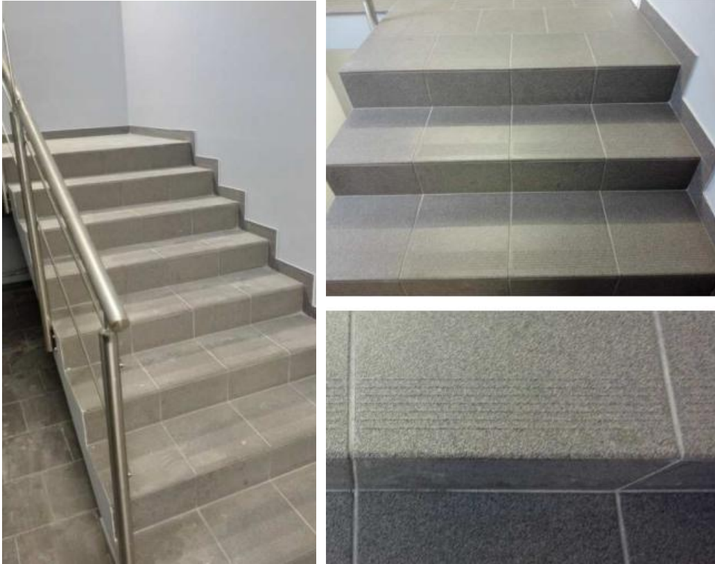
Laiptinės su akmens masės plytelių danga įrengimo pavyzdys. Pakopų apklėjavimas plytelėmis.
