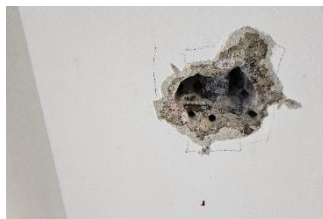
19 paveikslas. Rygelio sumontuoto rūsyje ašyje H, tarp ašių 4 – 5 armatūros atodanga
