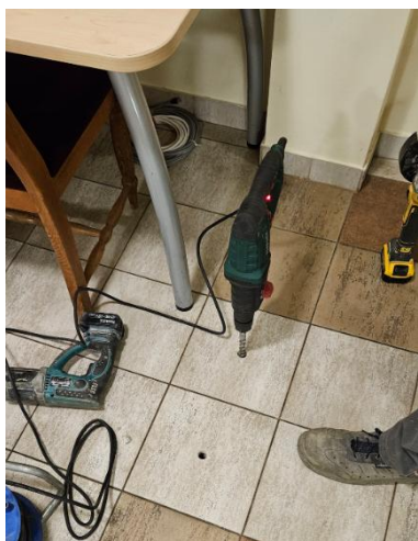
12 paveikslas. Stulpinių pamatų matmenų ir įgilinimo zondavimas
