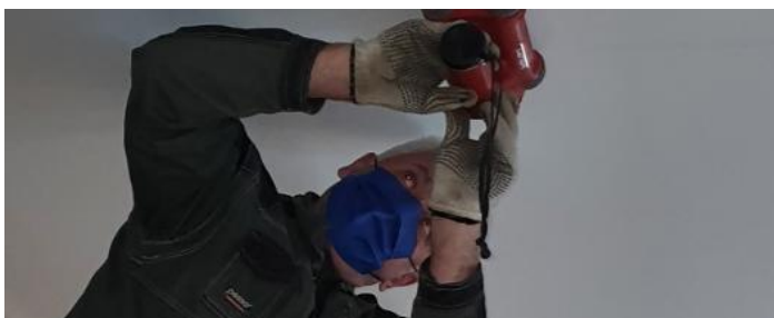
7 paveikslas. Gelžbetoninių perdangos plokščių armavimo tyrimas HILTI skeneriu
