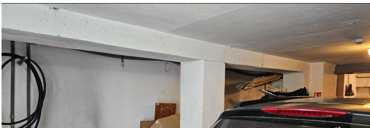
34 paveikslas. Rūsio surenkamos gelžbetoninės perdangos, sumontuotos ant mūrinių kolonų ir surenkamų gelžbetoninių ilginių, vaizdas
