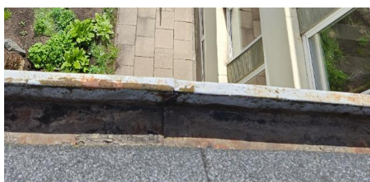
32 paveikslas. Lietaus vandens nutekėjimo vamzdžių būklės vaizdas
