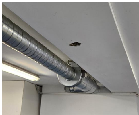
19 paveikslas. Rygelio sumontuoto rūsyje ašyje H, tarp ašių 4 – 5 armatūros atodanga
