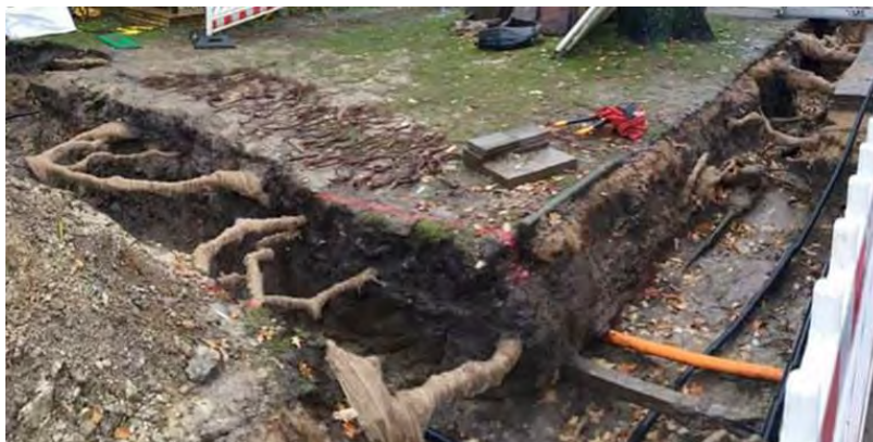
10 pav. Tranšėjos ir lovio kasimo išsaugant medžių šaknis pavyzdys
