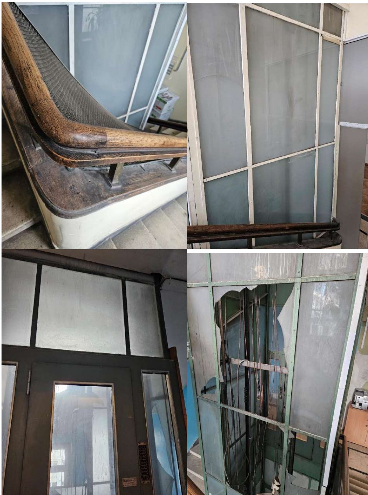
Autentiškos lifto šachtos fragmentai
