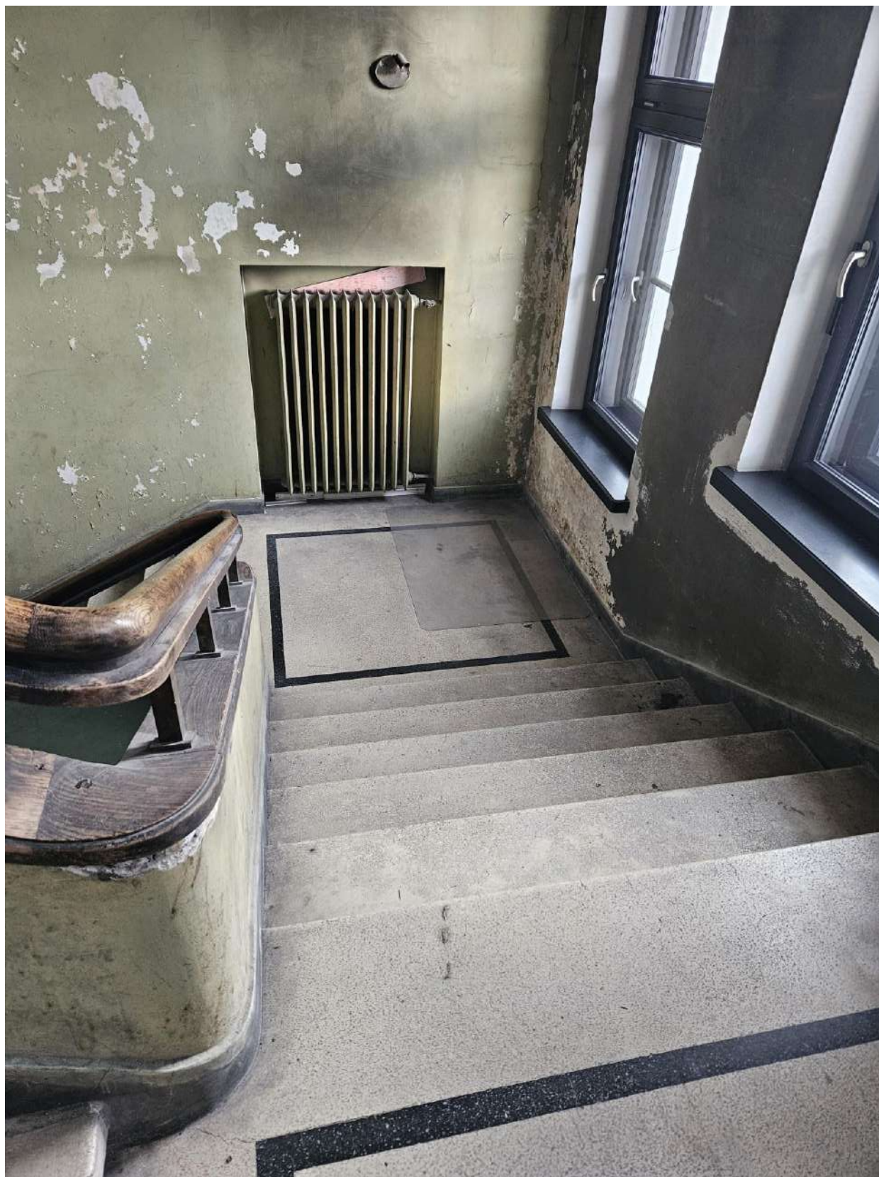
Centrinė laiptinė L1-vaizdas 3-6 aukštų
