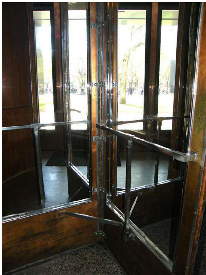
P fasado pagrindinio įėjimo metalo konstrukcijos įstiklintos sukamos durys,
