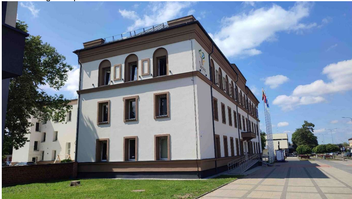
Fasadas iš gatvės pusės
