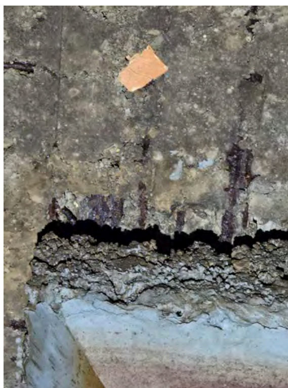
Pav. 8.8 Tarpas tarp kolonų galvučių ir perdangos
