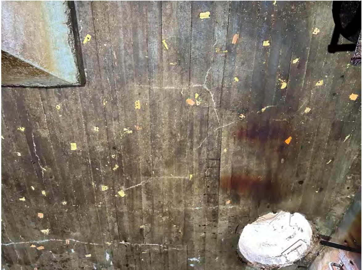
Pav. 8.1 Perdangos betono atsparumo gniuždymui matavimas
