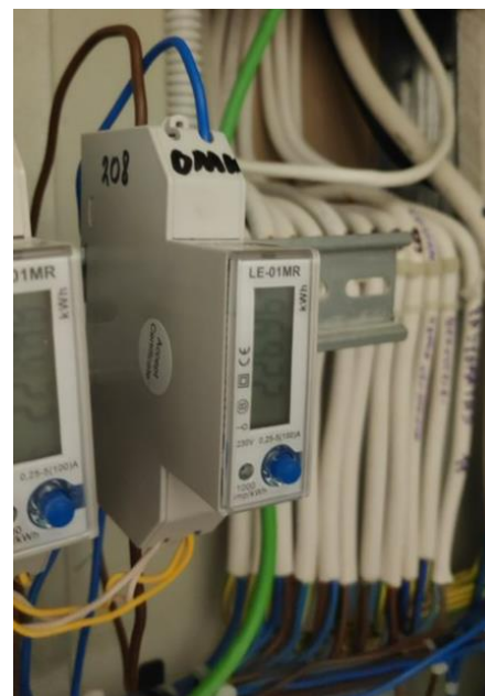
pav. 1 1F pakeistas elektros skaitiklis
