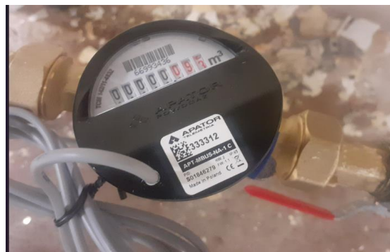
pav. 10 VS1.4 Sumontuotas papildomas Mbus modulis ant esamo skaitiklio
