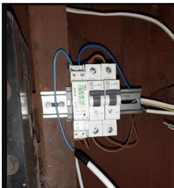
pav. 2 1F esamas elektros skaitiklis
