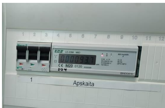
pav. 4 3F pakeistas elektros skaitiklis
