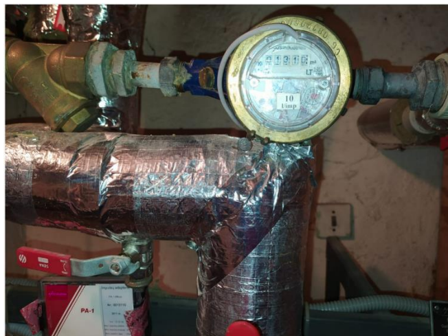
pav. 8 VS1.3 Sumontuota papildoma įranga ant esamo skaitiklio
