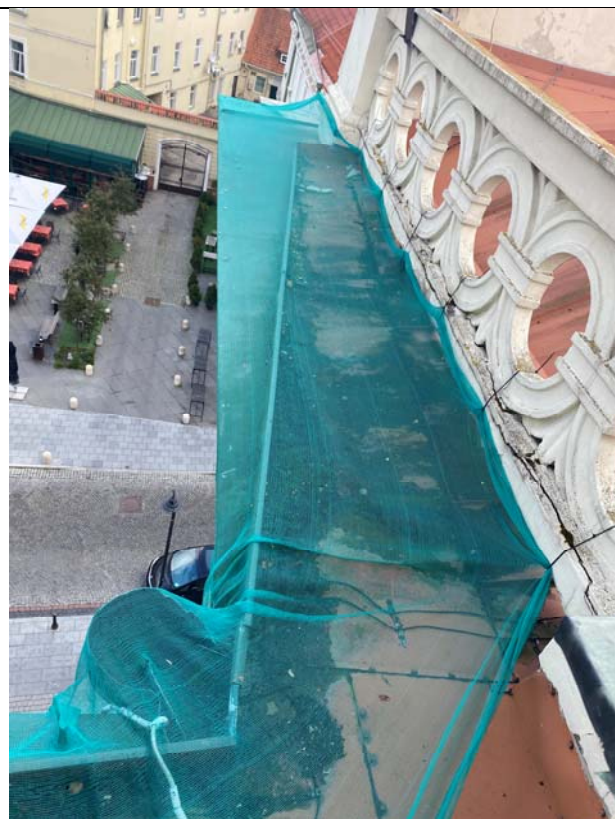
Karnizo apskardinimo ir lietaus surinko sistemos fragmentas. Apsaugai nuo nestabilių elementų keliamo pavojaus praeiviams- įrengtas tinkas
