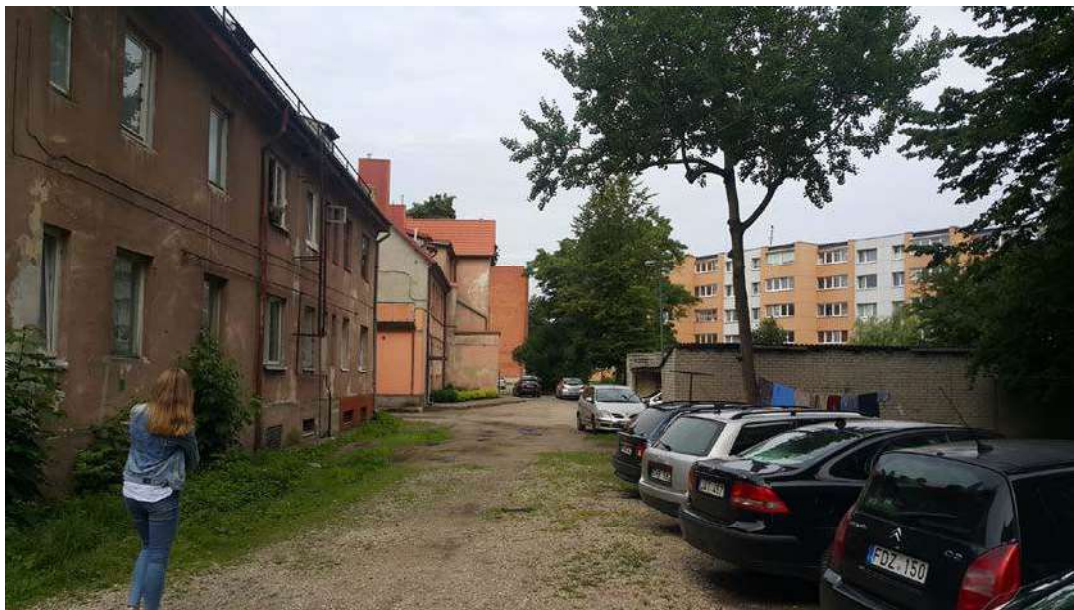
Tilžės g. 31 ir 29 kiemai. Vaizdas iš rytinės pusės
