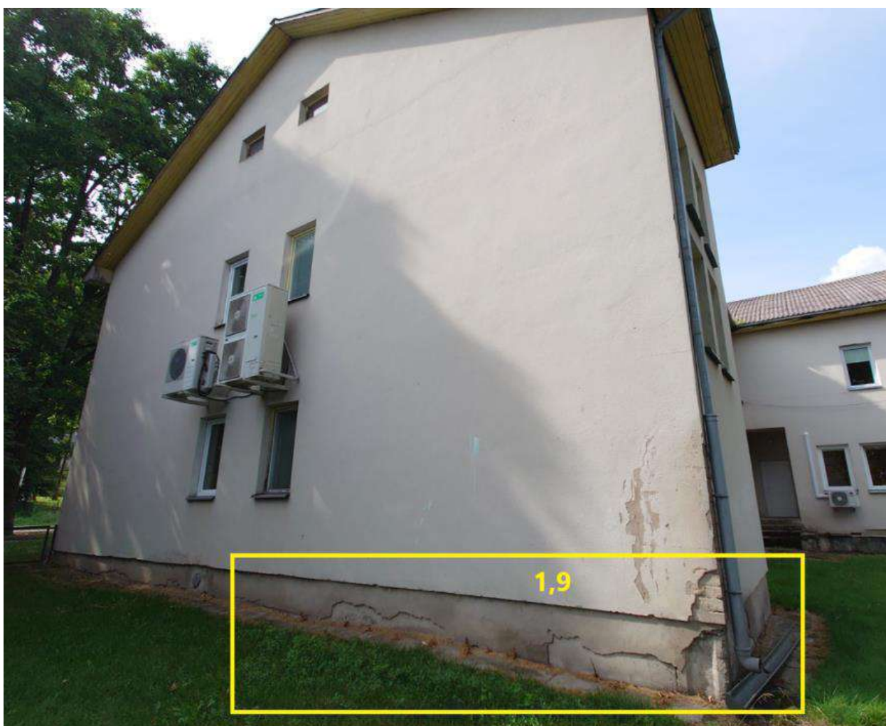
7 pav. Remontuojamo pastato fasado vaizdas
