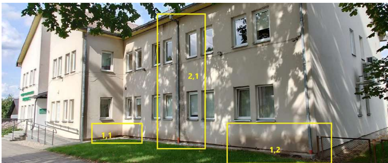
1 pav. Remontuojamo pastato fasado vaizdas.
