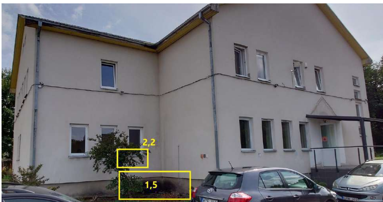
4 pav. Remontuojamo pastato fasado vaizdas.
