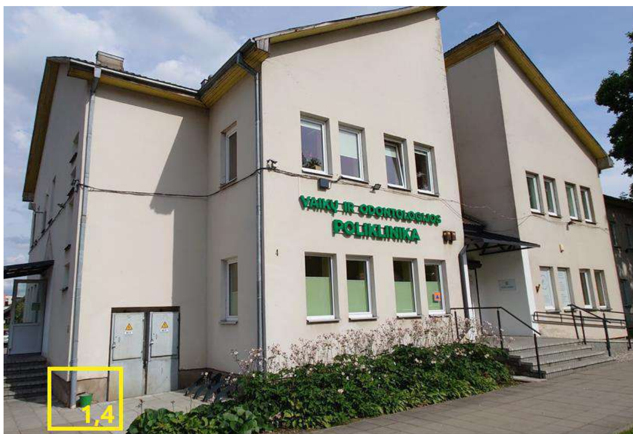
3 pav. Remontuojamo pastato fasado vaizdas.
