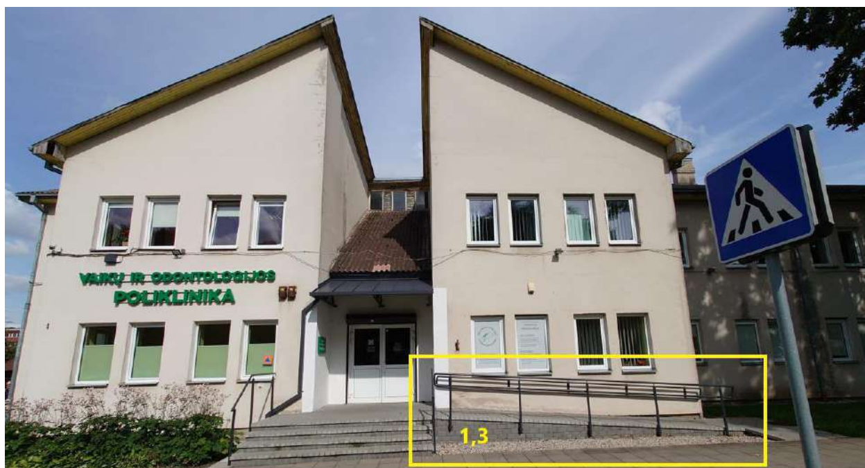
2 pav. Remontuojamo pastato fasado vaizdas.
