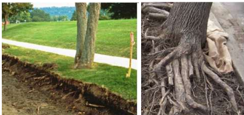
Pav. 8. Neigiami darbų pavyzdžiai - darbai atlikti netinkamai. Įrengiant iškasą, nutrauktos, nudraskytos šaknys.
