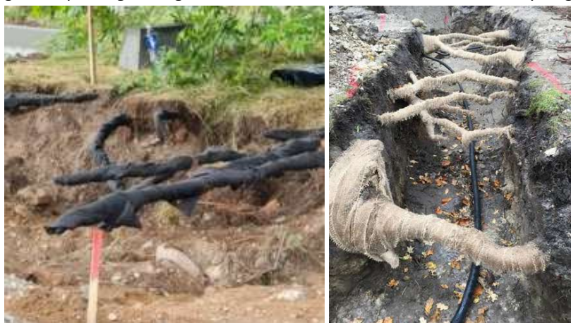
Pav. 7. Šaknų apgaubimas geotekstile, vykdančių darbus.
