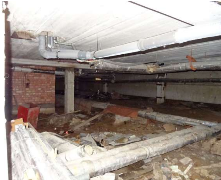
13 pav. Neapšiltinta rūsio perdanga.
