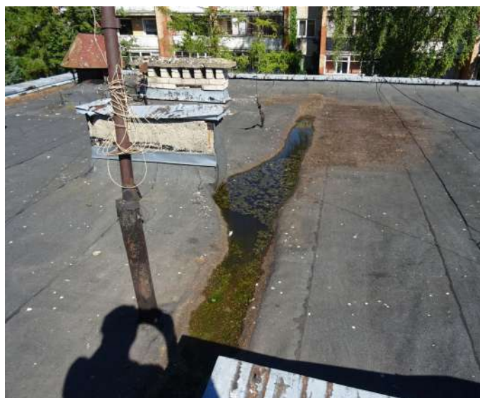
12 pav. Užsikimšusi stogo įlaja.
