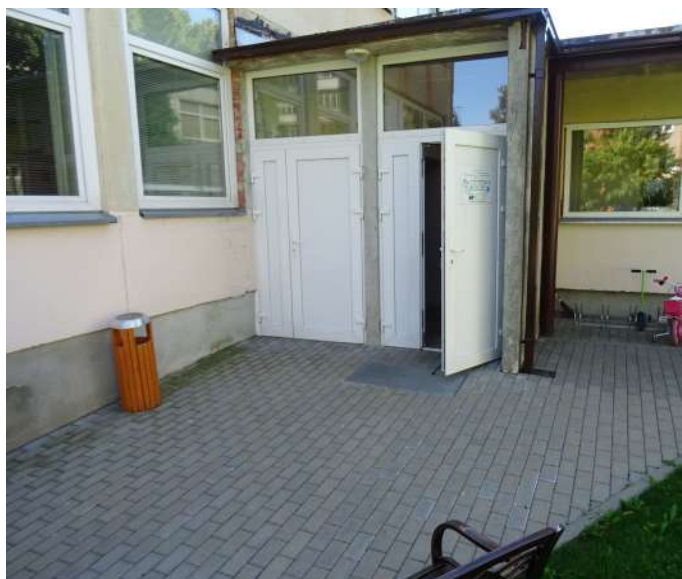
5 pav. Žmonių su negalia patekimui pritaikytas įėjimas į pastatą.
