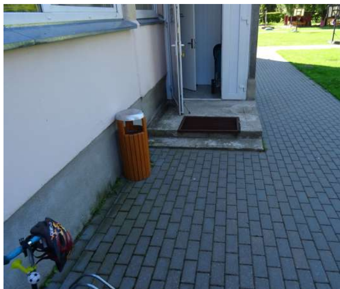
6 pav. Žmonių su negalia patekimui nepritaikytas įėjimas į pastatą.
