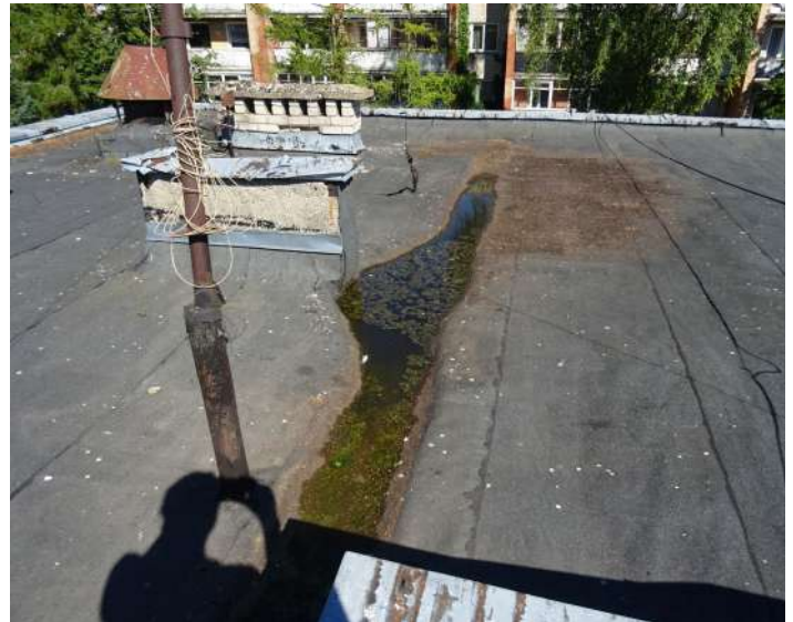
12 pav. Užsikimšusi stogo įlaja.
