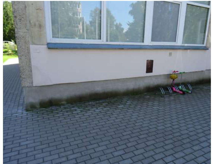
3 ir 4 pav. Bendras pastato cokolio vaizdas. Dėl blogai suformuoto pastato nuogrindos nuolydžio cokolis nuolat drėkinamas, atsiradę cokolio tinko patamsėjimai, tinkas vietomis įtrūkęs, apsamanojęs.
