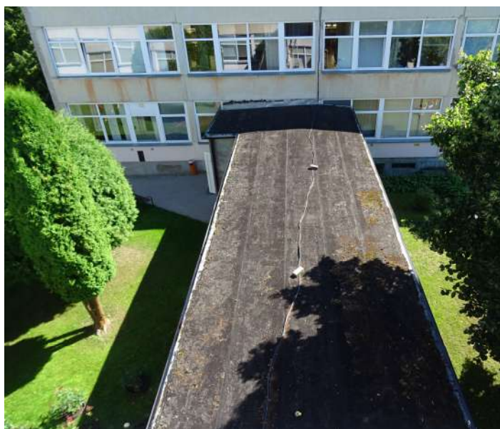
9 pav. Bendras galerijos stogo vaizdas. Stogas nuo pastato pastatymo nebuvo remontuotas, todėl jo danga susidėvėjusi, vietomis suplyšusi, nesandari, apsamanojusi. Stogo šilumos perdavimo charakteristikos neatitinka STR 2.01.02:2016 „Pastatų energinio naudingumo projektavimas ir sertifikavimas“ reikalavimų.
