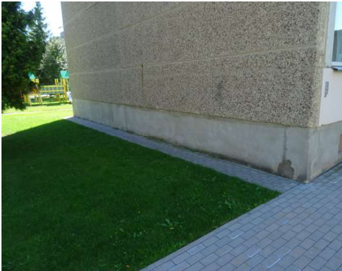
3 ir 4 pav. Bendras pastato cokolio vaizdas. Dėl blogai suformuoto pastato nuogrindos nuolydžio cokolis nuolat drėkinamas, atsiradę cokolio tinko patamsėjimai, tinkas vietomis įtrūkęs, apsamanojęs.
