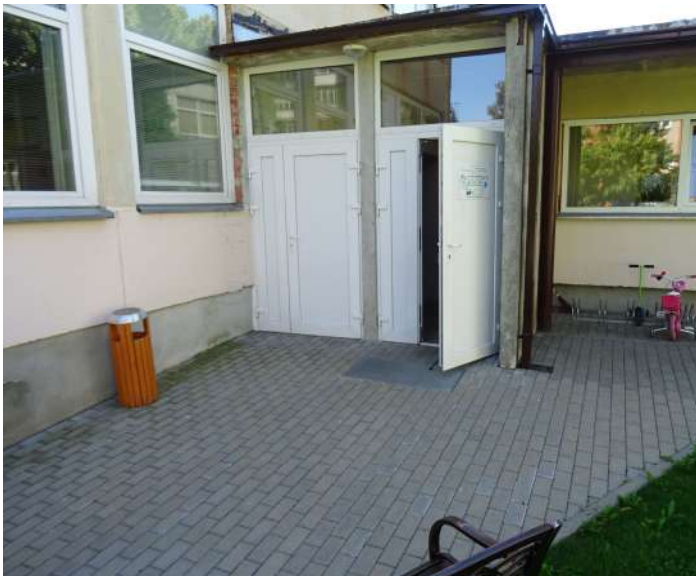
5 pav. Žmonių su negalia patekimui pritaikytas įėjimas į pastatą.
