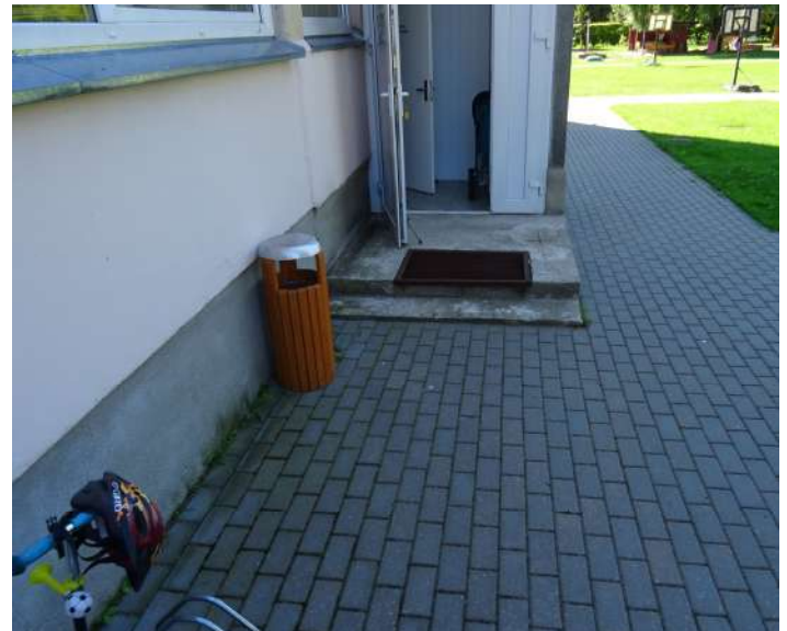
6 pav. Žmonių su negalia patekimui nepritaikytas įėjimas į pastatą.
