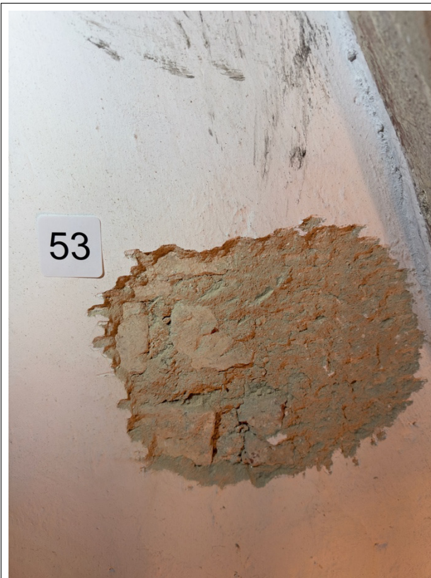
Zn53, Zn55 ant plytų mūro aptiktas tinko sluoksnis ir baltos spalvos dažymo sluoksnis
