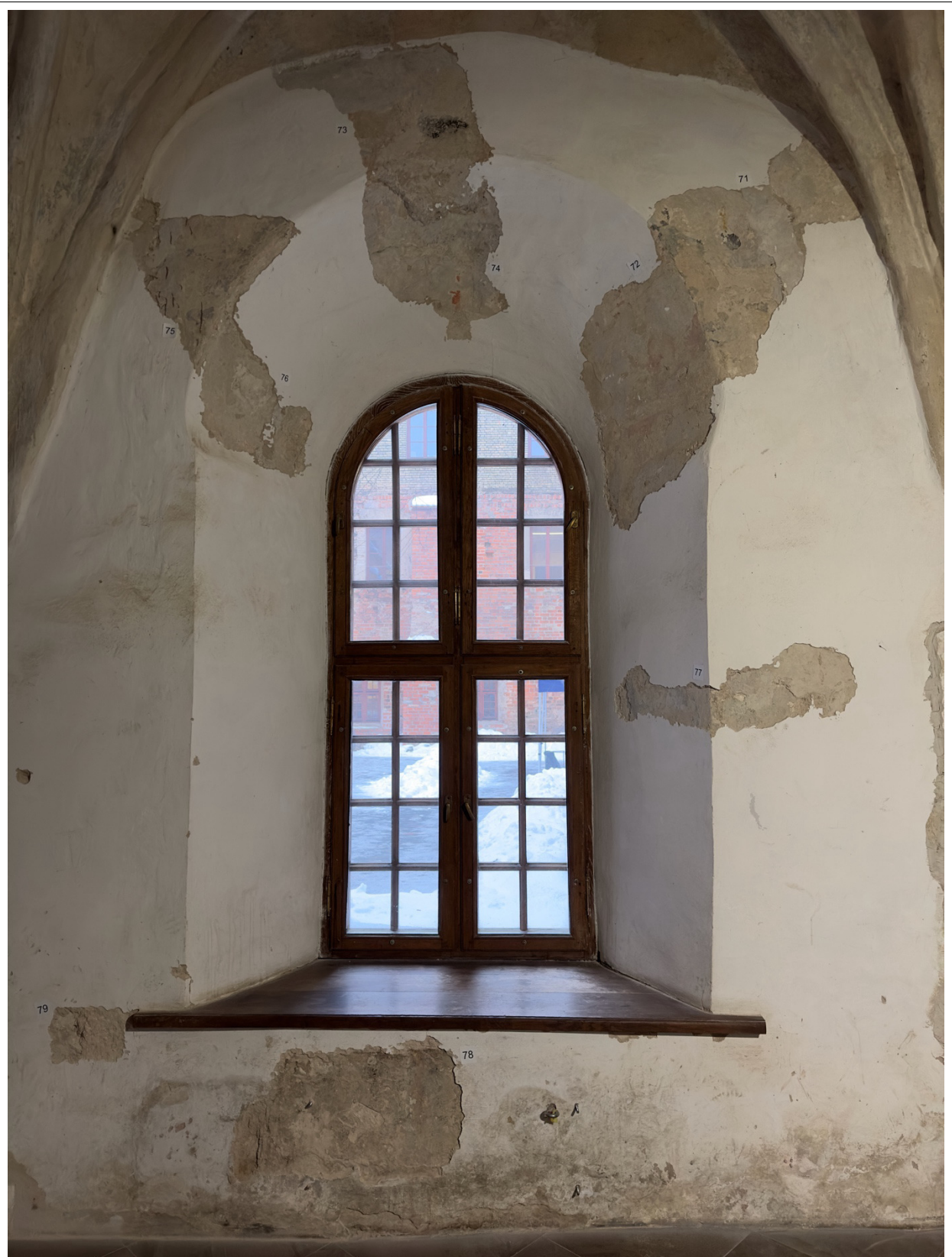
Procesijų rytinio koridoriaus vakarinės sienos dalis, trečiasis (R.V3) langas, V-oji travėja Viršutinėje sienos dalyje ir viršutinėje angokraščio dalyje aptikta ankstyvųjų dažymo
