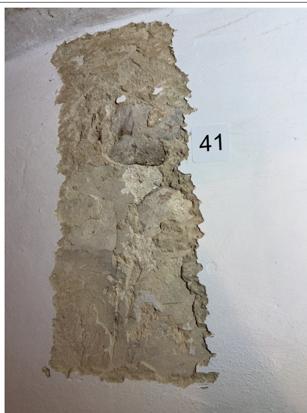
Zn41 Ankstyvųjų sluoksnių likučiai aptikti atskirais nedideliais plotais, dekoru neaptikta
