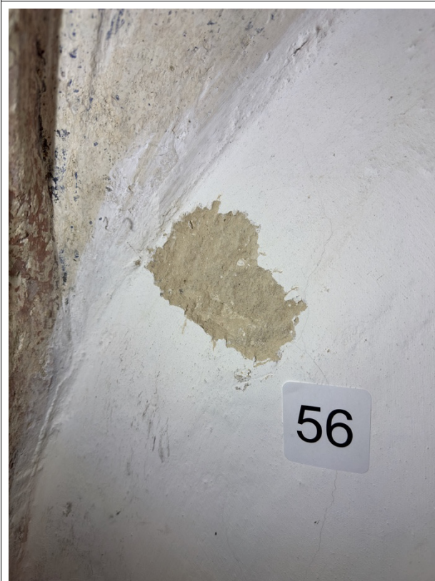
Zn53, Zn55 ant plytų mūro aptiktas tinko sluoksnis ir baltos spalvos dažymo sluoksnis
