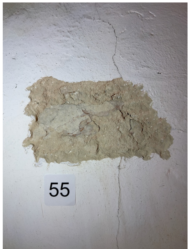
Zn53, Zn55 ant plytų mūro aptiktas tinko sluoksnis ir baltos spalvos dažymo sluoksnis
