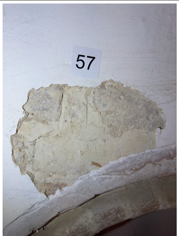
Zn53, Zn55 ant plytų mūro aptiktas tinko sluoksnis ir baltos spalvos dažymo sluoksnis
