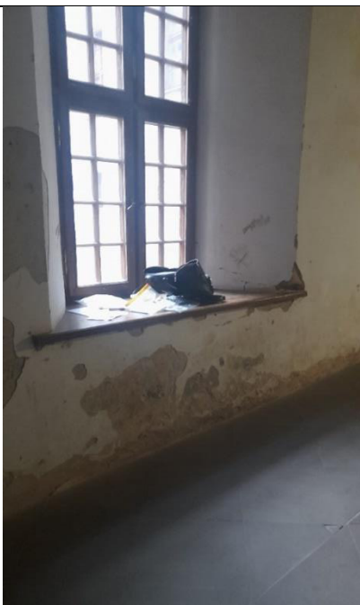
3 pav. Procesijų rytinio koridoriaus vakarinė siena galimai pažeista mikrogrybais
