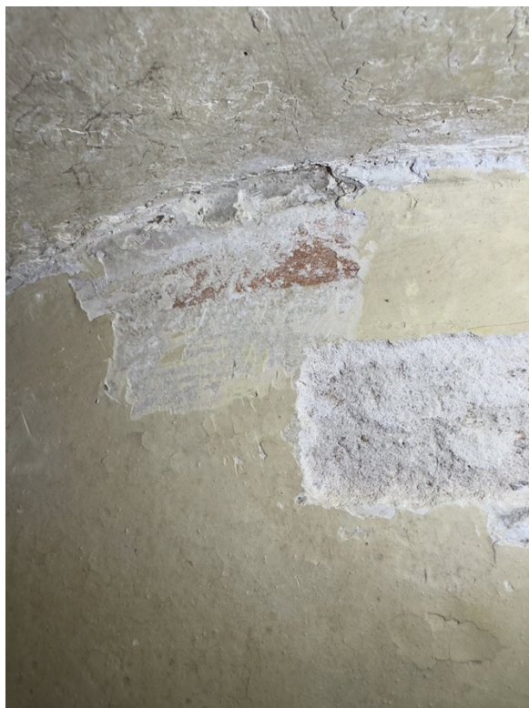
Zn34 Ankstyvieji sluoksniai likę tik prie skliautų vidiniame sienos ir skliauto sandūros kampe
