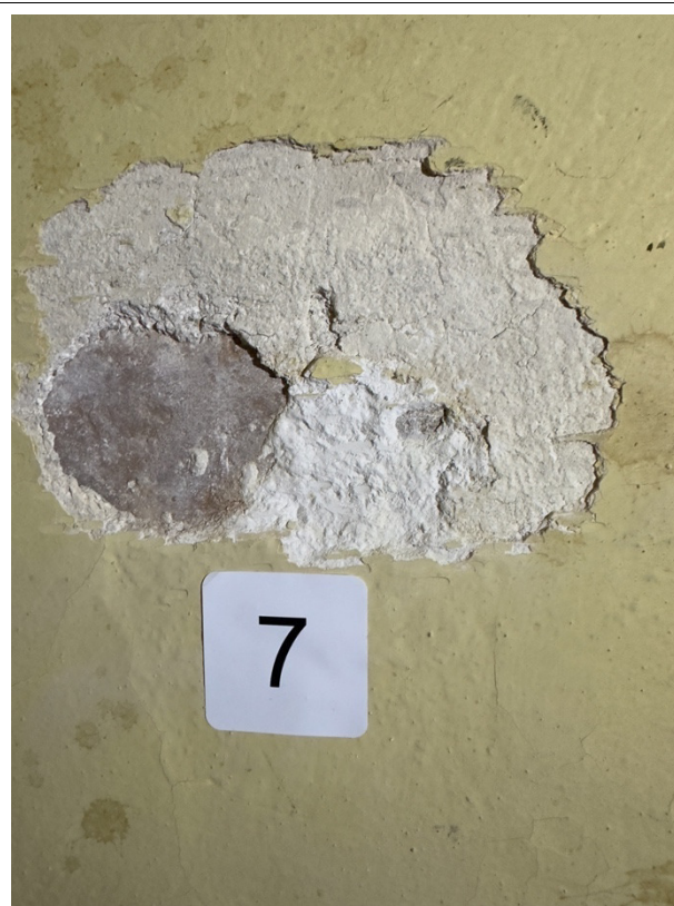
Zn7, Zn10 Vėlyvas tinkas ir vėlyvi dažymų sluoksniai
