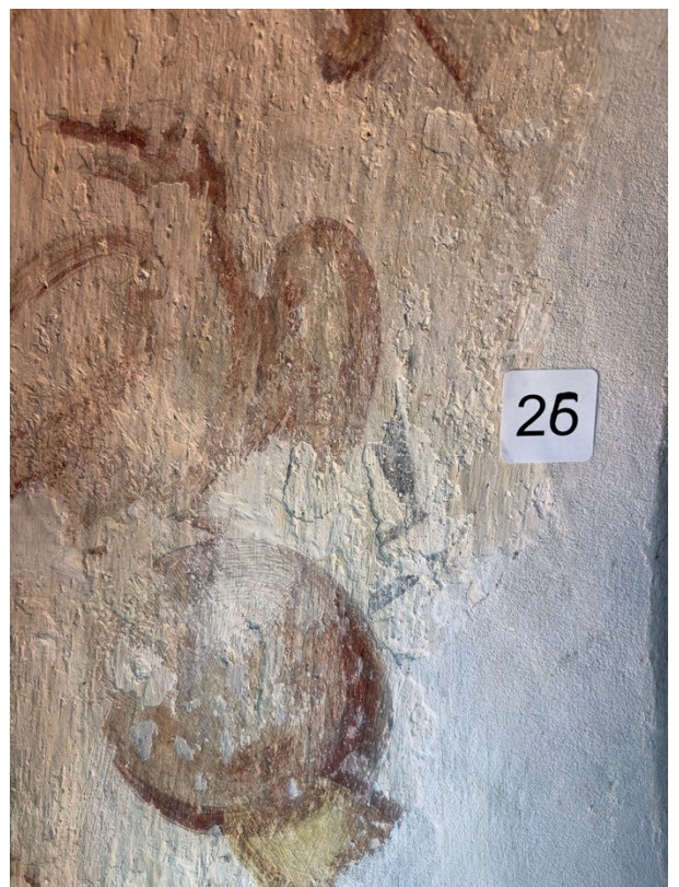
Zn25, Zn26 Po atidengta ir restauruota tapyba atidengtas zondas, matoma tamsiai pilkos spalvos (galimai augalinių motyvų) tapyba
