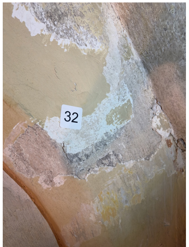
Zn31, Zn32 Aptikta tamsiai pilkos spalvos dekoratyvinė juostelė arkinės lango angos apatinės plokštumos ir sienos sandūroje
