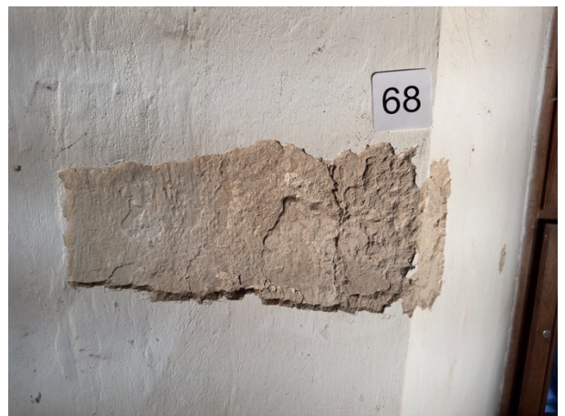
Zn67, Zn68 Po vėlyvaisiais sluoksniais aptiktas sluoksnio su dekoru likučiais likučiai. Sluoksniai trapūs, sukibę
