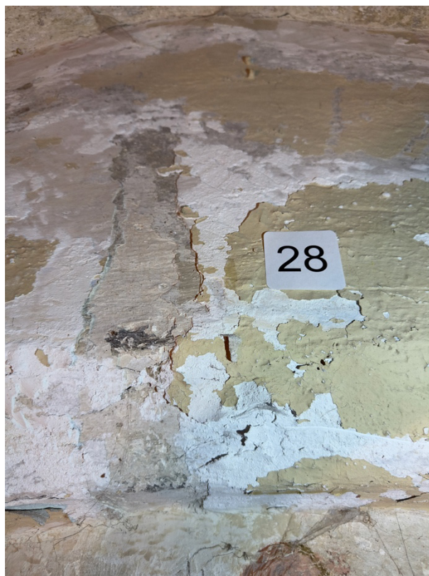
Zn28 Aptikta tamsiai pilkos spalvos dekoratyvinė juostelė arkinės lango angos apatinės plokštumos ir sienos sandūroje
