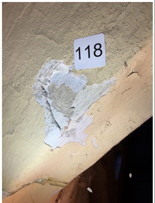
Zn118 Aptikta bordo spalvos juostelė prie arkinės angos apatinės plokštumos ir sienos sandūros
