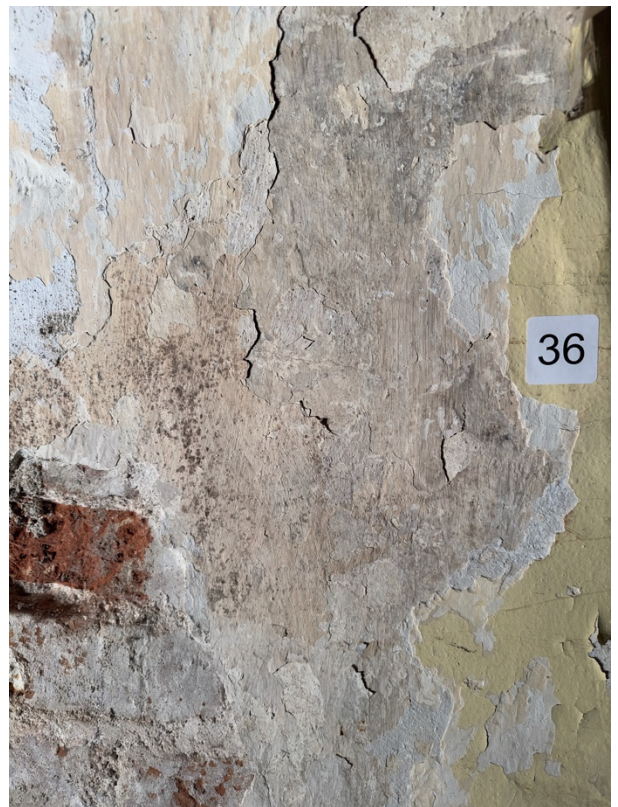
Zn16, Zn36 Ankstyvieji sluoksniai sukibę, trapūs, dekoru neaptikta
