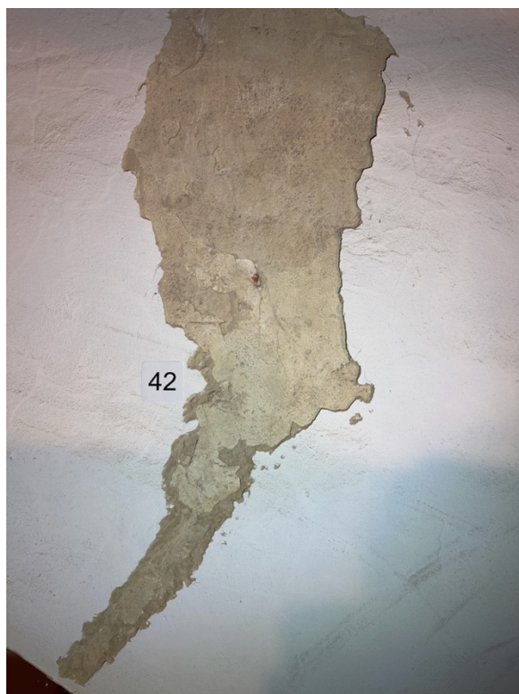
Zn42 Ankstyvųjų sluoksnių likučiai aptikti atskirais nedideliais plotais, dekoru neaptikta
