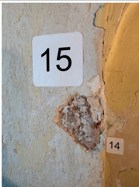
Zn15, Zn35 Vėlyvas tinkas ir vėlyvi dažymų sluoksniai
