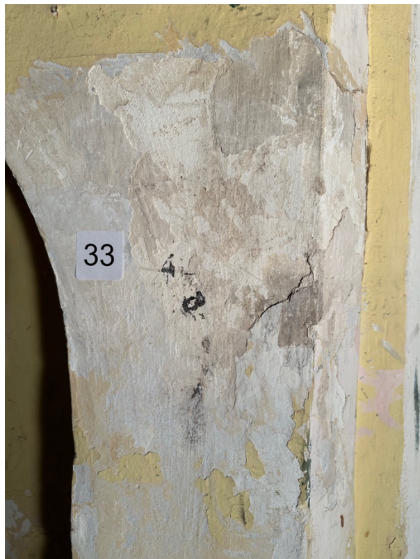
Zn25, Zn26 Po atidengta ir restauruota tapyba atidengtas zondas, matoma tamsiai pilkos spalvos (galimai augalinių motyvų) tapyba
