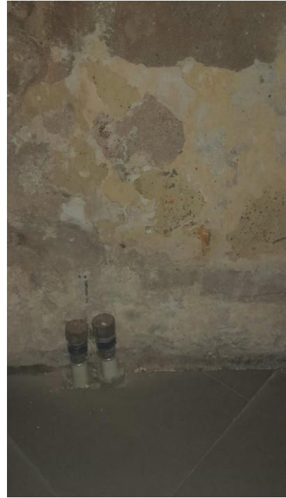
2 pav. Galimai mikrogrybais pažeistas paviršius
