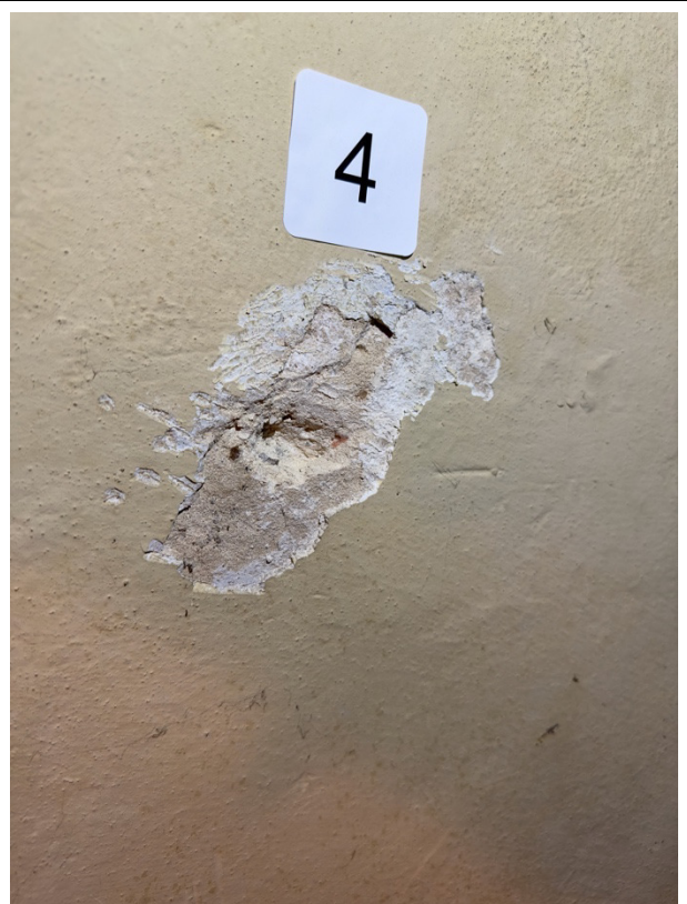
Zn4 Vėlyvas tinkas ir vėlyvi dažymų sluoksniai
