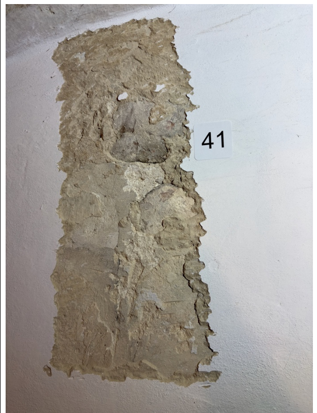
Zn41 Ankstyvųjų sluoksnių likučiai aptikti atskirais nedideliais plotais, dekoru neaptikta
