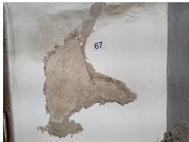
Zn67, Zn68 Po vėlyvaisiais sluoksniais aptiktas sluoksnio su dekoru likučiais likučiai. Sluoksniai trapūs, sukibę
