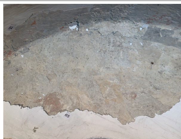
Zn65, Zn66 Po vėlyvaisiais sluoksniais aptiktas sluoksnis su su bordo, juodos, geltonos spalvos likučiais. Sluoksnis trapus, sukibęs su vėlyvaisiais dažymais
