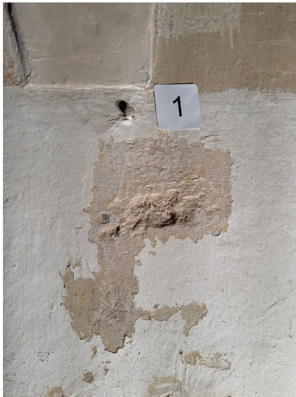
Zn1, Zn2 Vėlyvas tinkas ir vėlyvi dažymų sluoksniai
