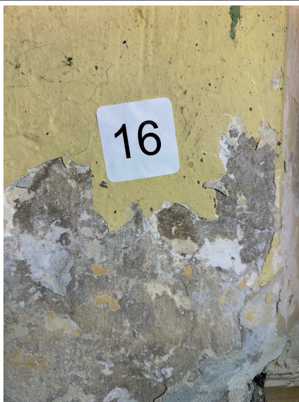
Zn16, Zn36 Ankstyvieji sluoksniai sukibę, trapūs, dekoru neaptikta
