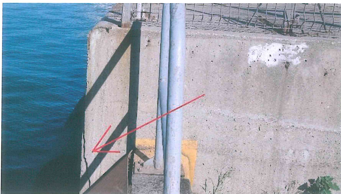
5 pav. Plyšys antstato fasadinėje dalyje ties 3 ir 4 krantinių sandūra (supleišėjęs antstatas priklauso 3 krantinei)
