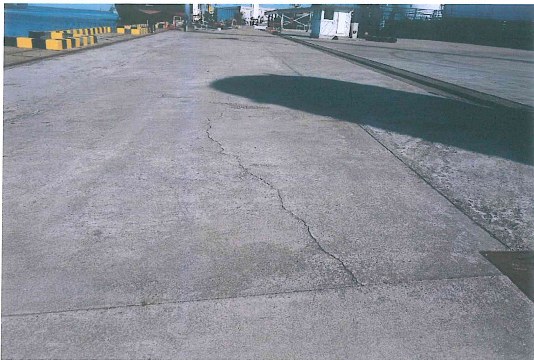
3 pav. Krantinės danga nusėdusi ir supleišėjusi
