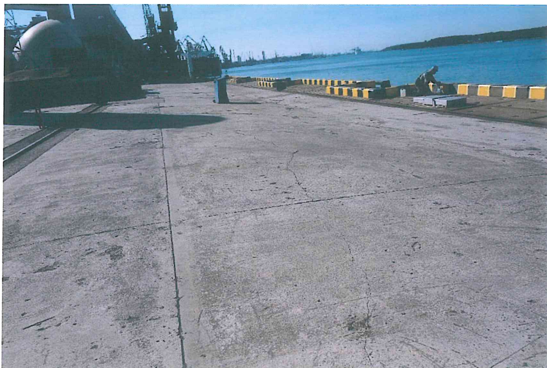
7 pav. Monolitinė danga supleišėjusi išilginiais plyšiais
