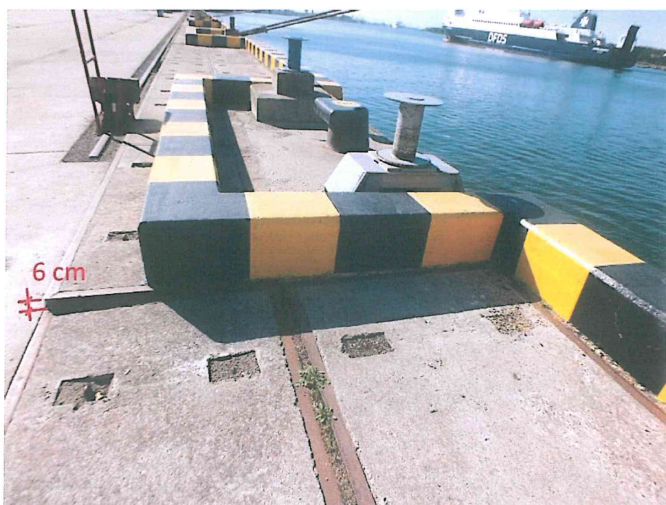
6 pav. Dalis inžinerinių tinklų perdengimo plokščių nusėdusios
