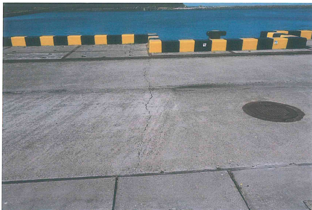
8 pav. Skersiniai plyšiai teritorijos dangoje, jų yra ne vienas
