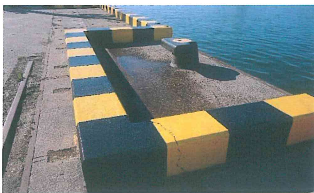
11 pav. Ratų atmušos vaizdas. Viršuje – apdaužytas, apačioje – supleišėjęs
