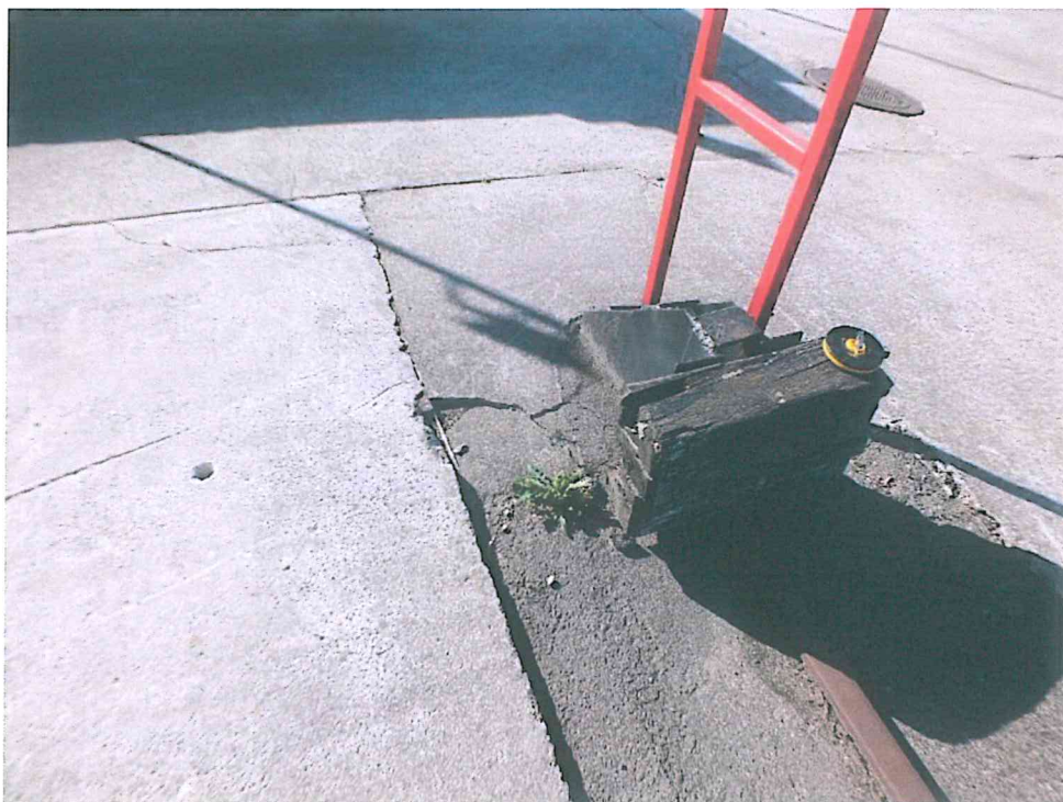
9 pav. Galinių krano bėgių atsparų mediniai elementai supuvę, danga ties jais apirusi
