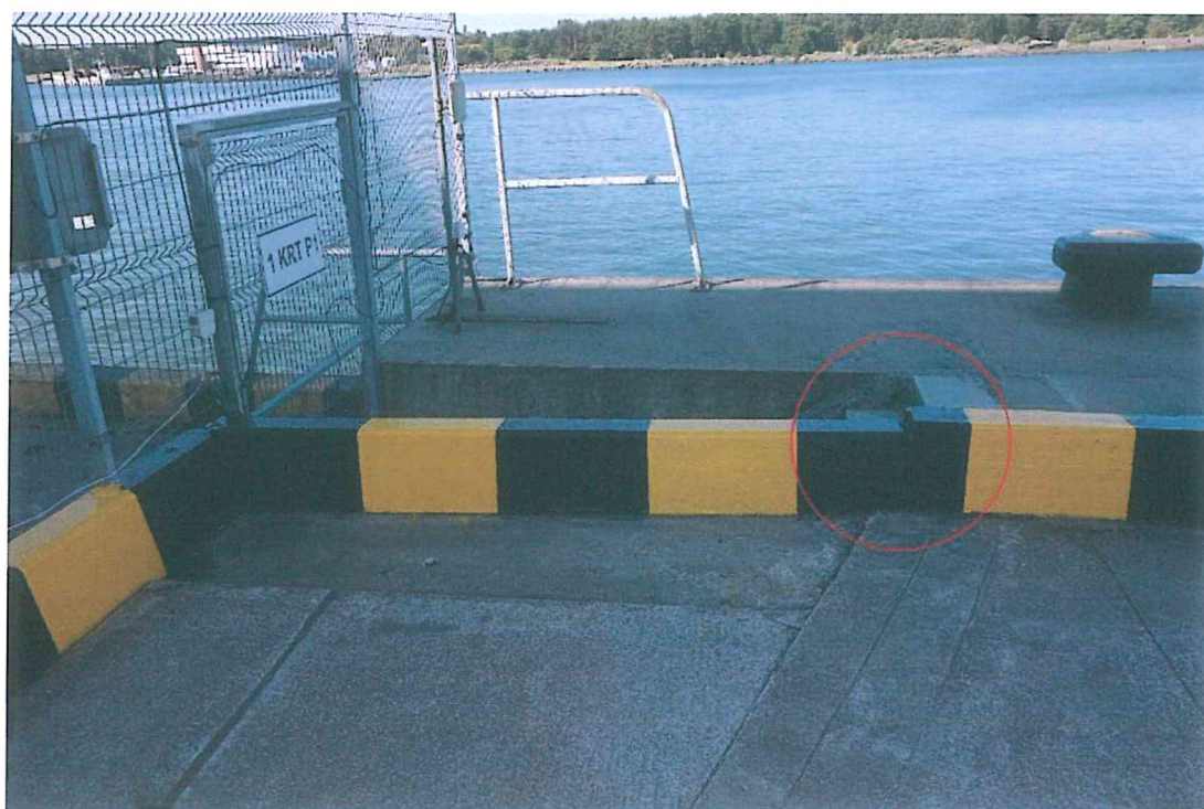
4 pav. Krantinės dangos ir atmušos bloko nusėdimas netoli sandūros su 4 krantine
