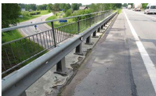
2.4 pav. Peršlapę ir išbyrėję kairės pusės šalitilčio kraštai palei važiuojamąją kelio dangą
