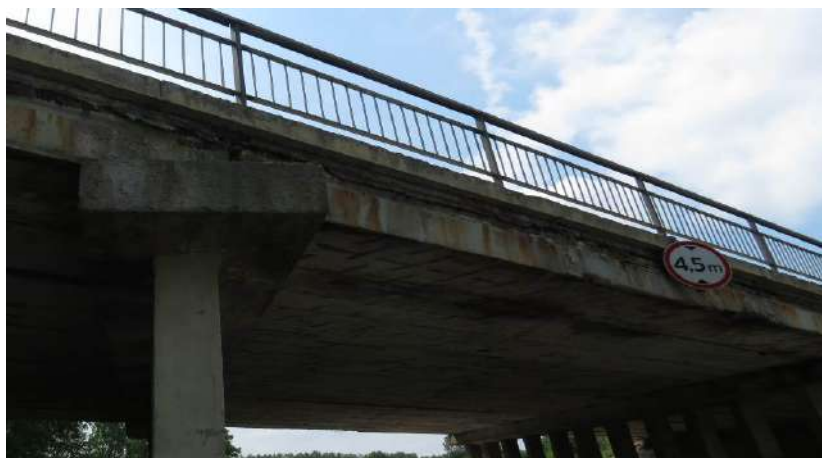
3.1 pav. Viaduko antrojo tarpatramio perdangos bendras vaizdas
