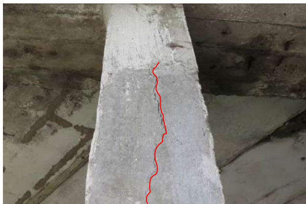
2.20 pav. Antros atramos 12 kolonos bendras vaizdas. Kolona supleišėjusi išilginiais plyšiais, koroduoja pagrindinę ir pagalbinę armatūrą
