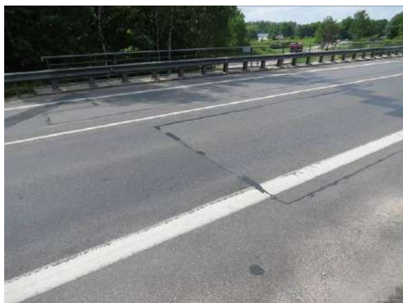
2.1 pav. Dangos bendras vaizdas. Vietomis danga įdubusi, susiformavę provėžos
