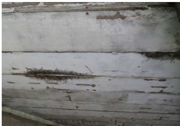
2.6 pav. Pirmojo tarpatramio perdangos bendras vaizdas. Kiaura hidroizoliacija. Per tarpus tarp plokščių sunkiasi vanduo ir karbonatiniai produktai
