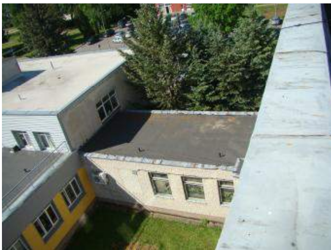
29. Vienaukštės pastato dalies stogas tarp ašių 4-5
