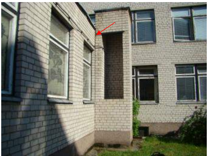
16. Nuo pastato iki 10 mm pasviręs priestatas ties ašimis 4-E
