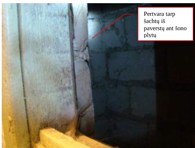
21. Vėdinimo šachtos vaizdas rūsyje prie patalpos R-16
