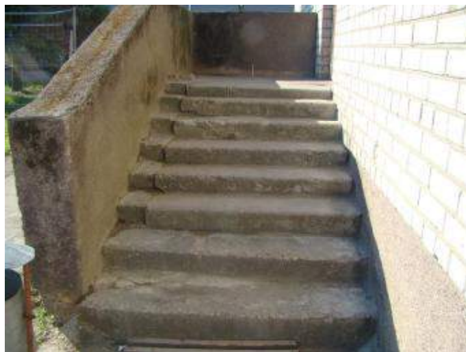
18. Laiptų pakopos nelygios, aptrupėjusios, nevientisos, neįrengtas porankis
