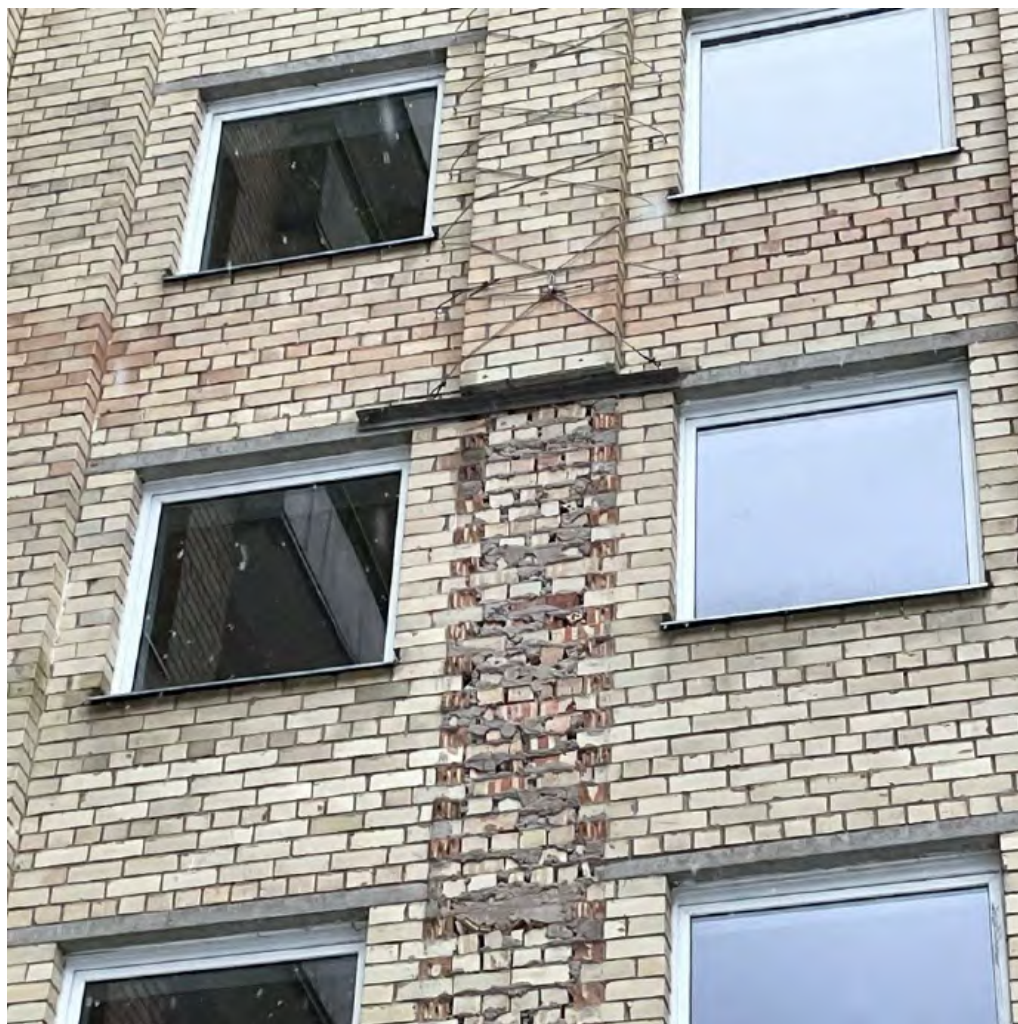
7 pav. Piliastro tvirtinimo konstrukcija
