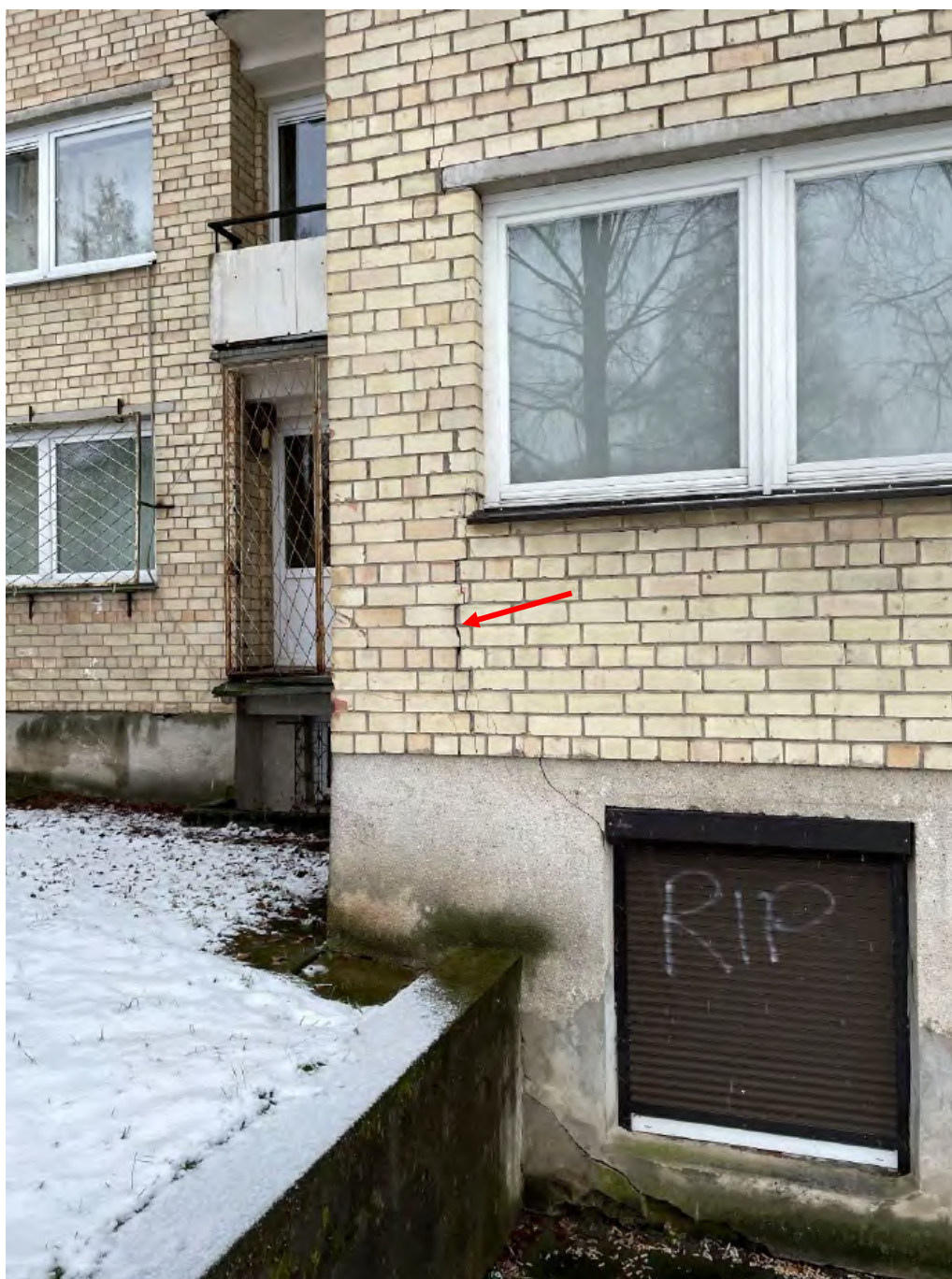
8 pav. Plyšys mūre sienų susikirtimo zonoje
