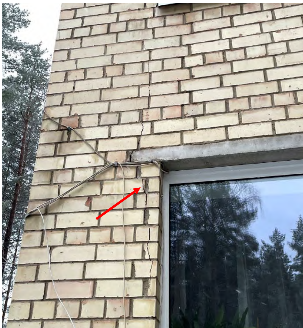
6 pav. Plyšys mūre ties sargamos atrama
