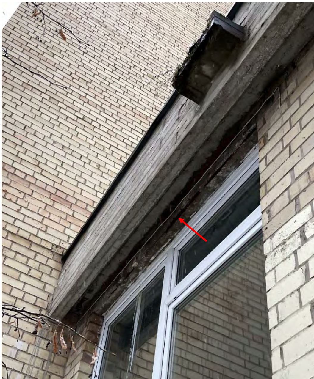
9 pav. Korozijos pažeista gelžbetoninė sàrama vakarinėje pastato dalyje
