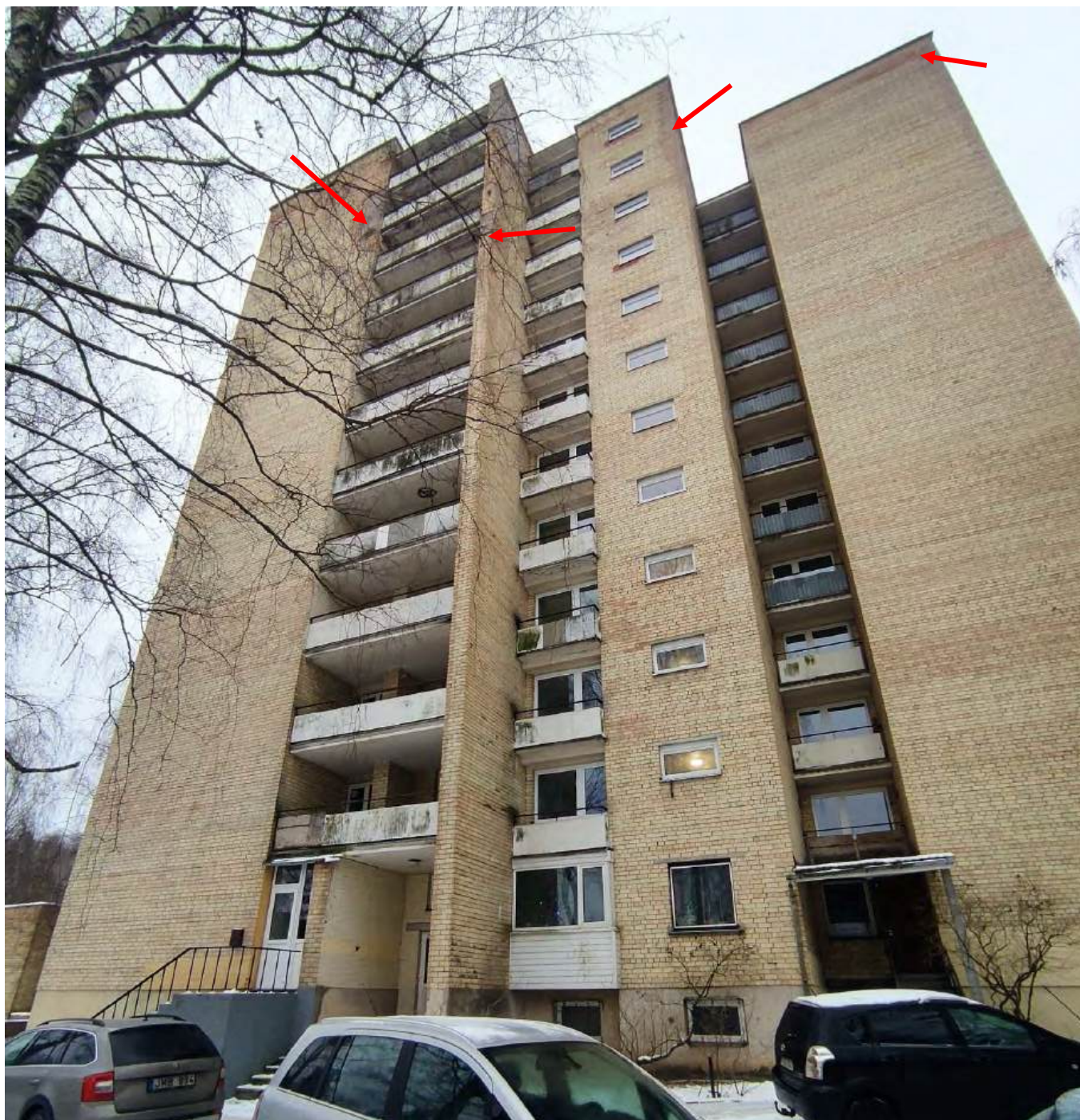
4 pav. Pietų-rytų fasado fragmentas (erozijos pažeistas mūras)
