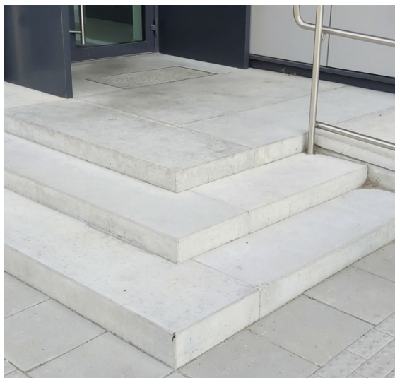
Dekobetono laiptų architektūrinė raiška (statūs kampai, lygios briaunos, betono spalva, siūlės)
