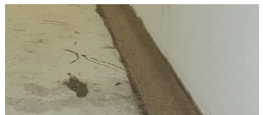
Pav.10 Grindjuostės formavimas naudojant tiksotropinę masę iš kvarcinio smėlio, epoksidinių dervų užpildo, tikotropinio priedo ir skaidraus epoksidinio rišiklio.
