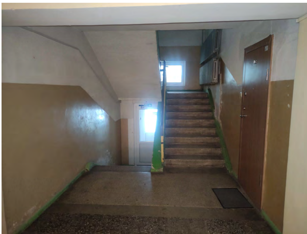
Vidinės sienos ir pertvaros-plytų mūras, laiptai – surenkamo gelžbetonio.
