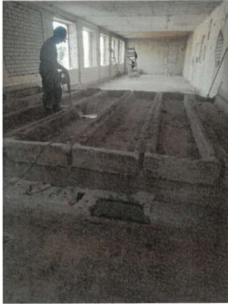
Pav.7. Lovinė perdanga 2 aukšte, tarp ašių C2 ir D.
