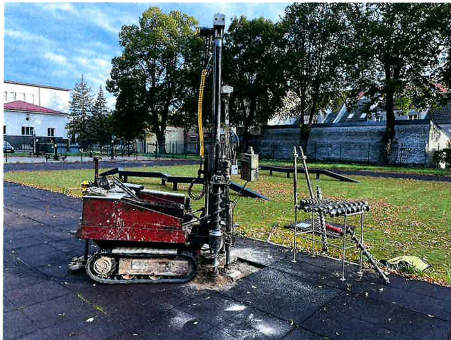
3 pav. Inžinerinių geologinių ir geotechninių tyrimų vieta (Gr.,CPT,DPSH-3).
