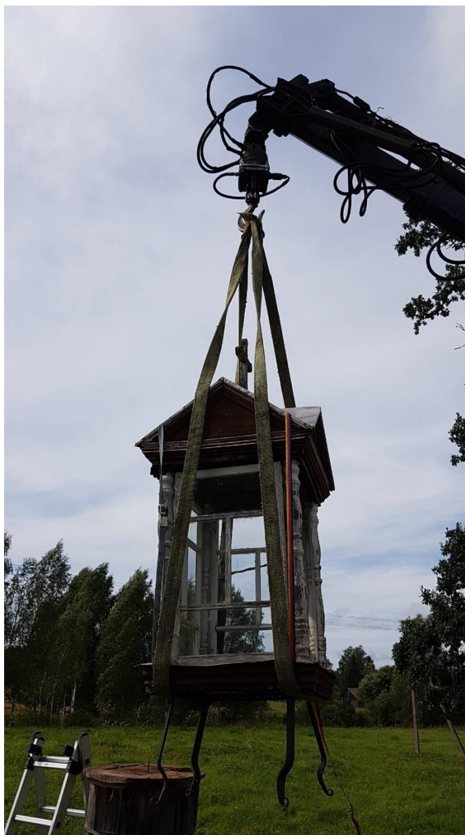
Bendras vaizdas išmontuojant koplytstulpį
