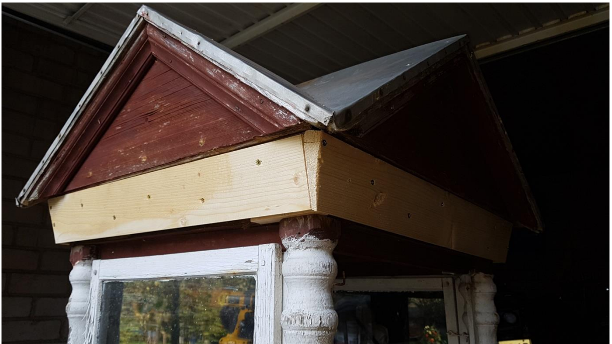
Sunykusių elementų atkūrimas
