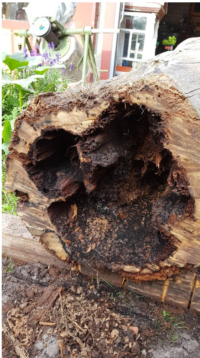
Išpuvusi koplytstulpio apačia
