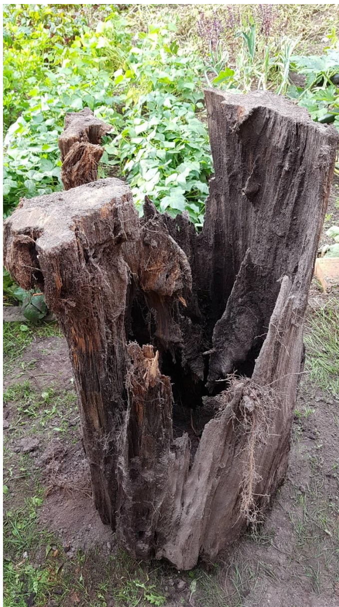
Išpuvusi koplytstulpio apačia
