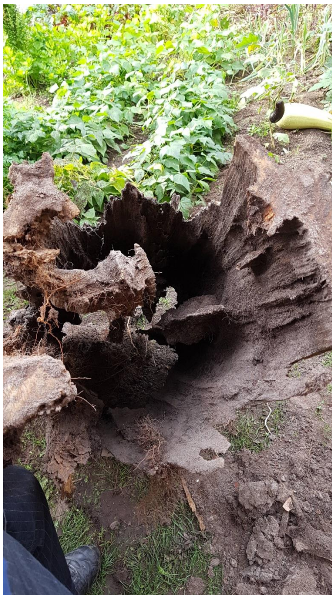
Išpuvusi koplytstulpio apačia
