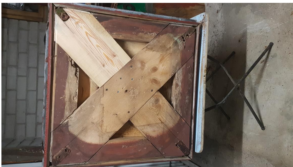
Koplytėlės supuvusios konstrukcijos atkūrimas
