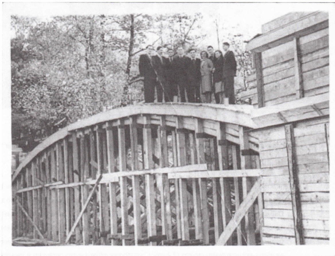
2.1 pav. Užbetonuoti ramtai ir perdanga, ant nuotraukos užrašyta: „Su pastoliais, 1953 m.“
