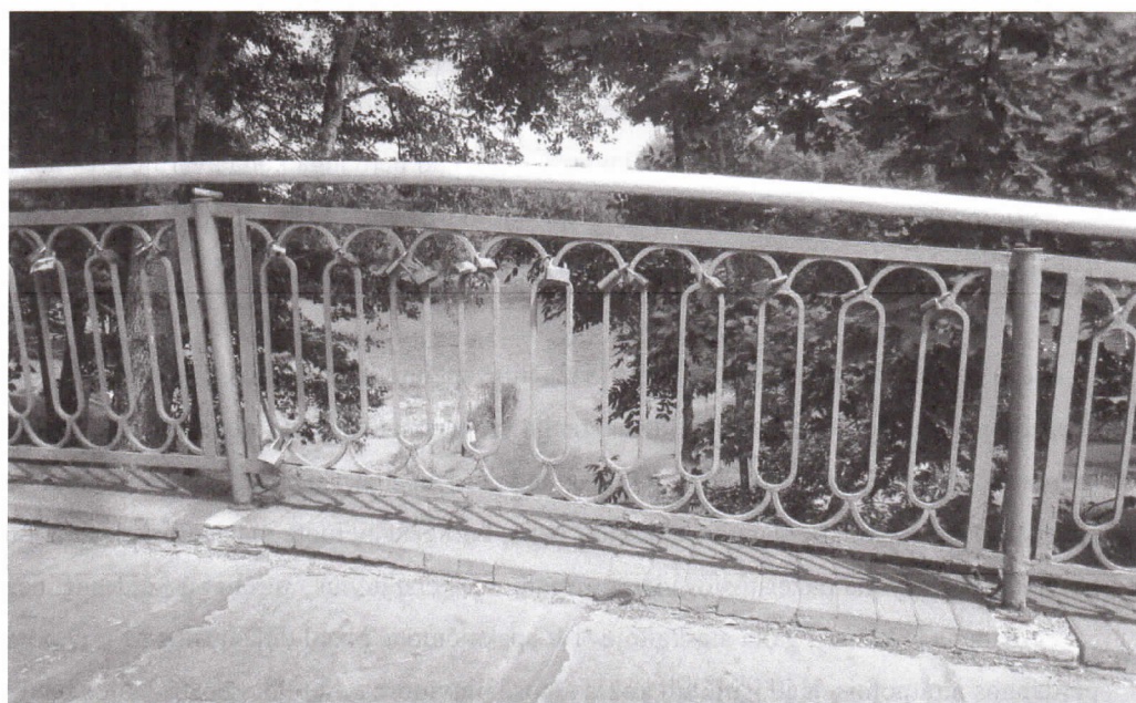
2.4 pav. Dabartinių turėklų fragmentas. Turėklų užpildo viršutinė dalis visiškai
