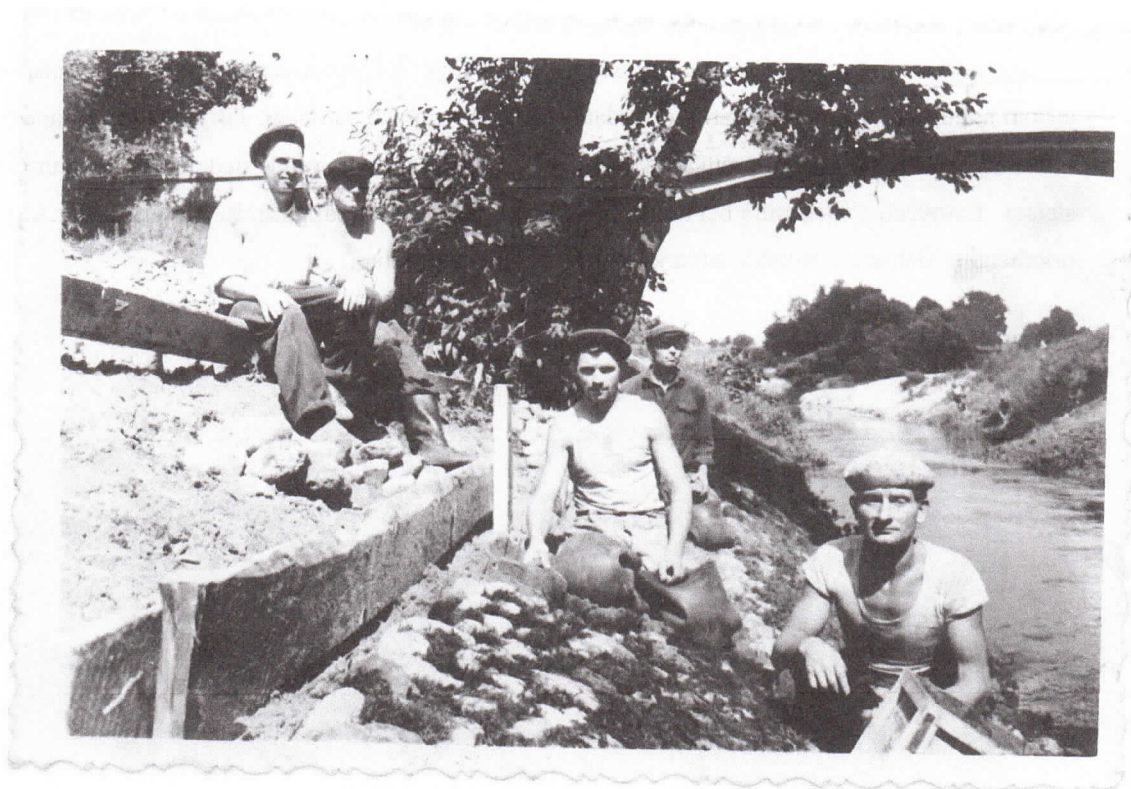
2.2 pav. Šlaito stiprinimas akmens grindiniu. Ant nuotraukos užrašyta: „Tiltelio statytojai“ (Foto iš Druskinikų muziejaus fondų)
