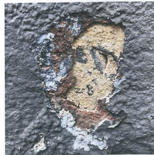
F-13. PR fasadas, cokolio sienos plokštuma. Zondažas Z-8, SL-1.
