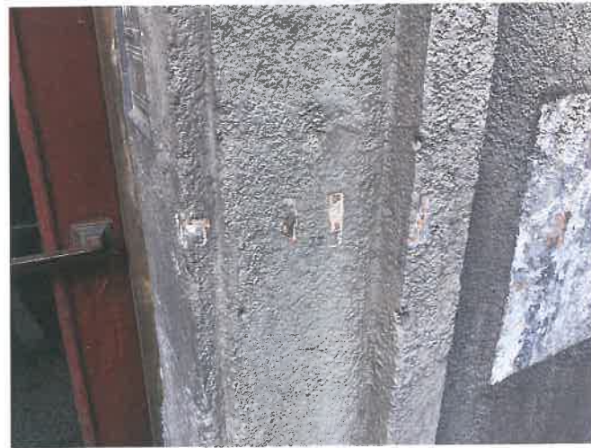
F-7. PR fasadas, profiliuoto durų angos apvado fragmentas. Zondažų Z-3, Z-4 ir Z-5 situacija.
