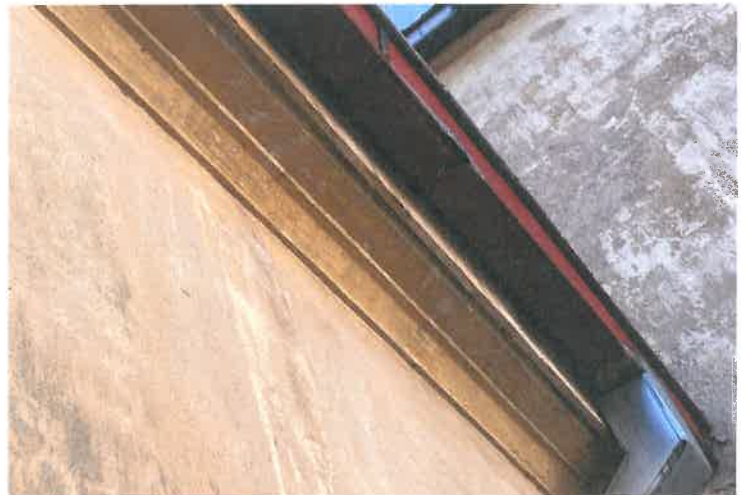
F-22. ŠV fasado pastogės karnizo fragmentas.
