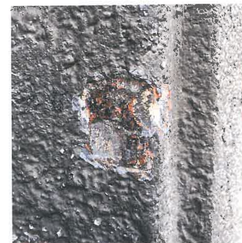
F-10. PR fasadas, profiliuotas durų angos apvadas. Zondažas Z-5, SL-1.
