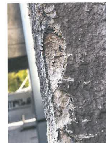
F-16. PR fasadas, profiliuotas laiptinės aprėminimas. Zondažas Z-13, SL-2.
