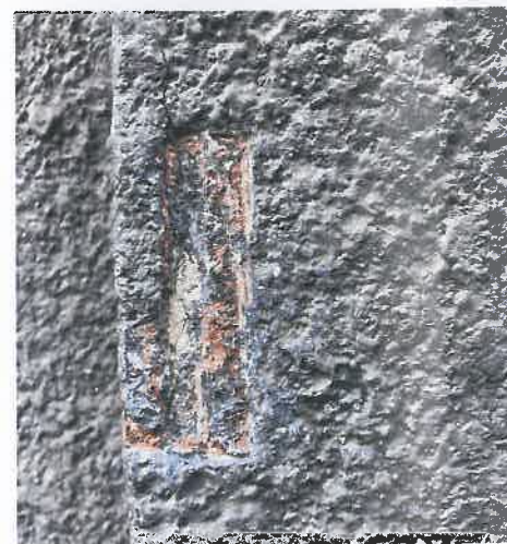
F-8. PR fasadas, profiliuotas durų angos apvadas. Zondažas Z-3, SL-1.
