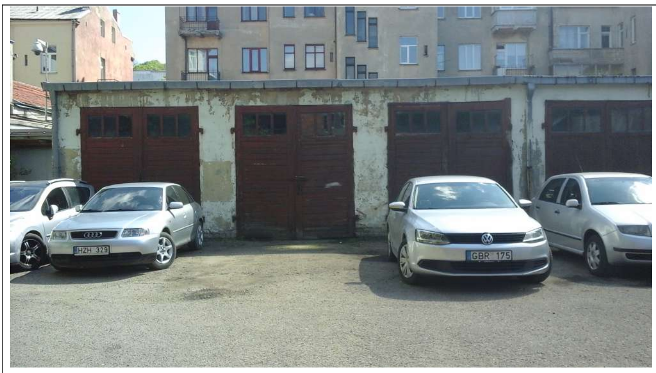
2 pav. lietvamzdžio esamos būklės foto fikšacija
