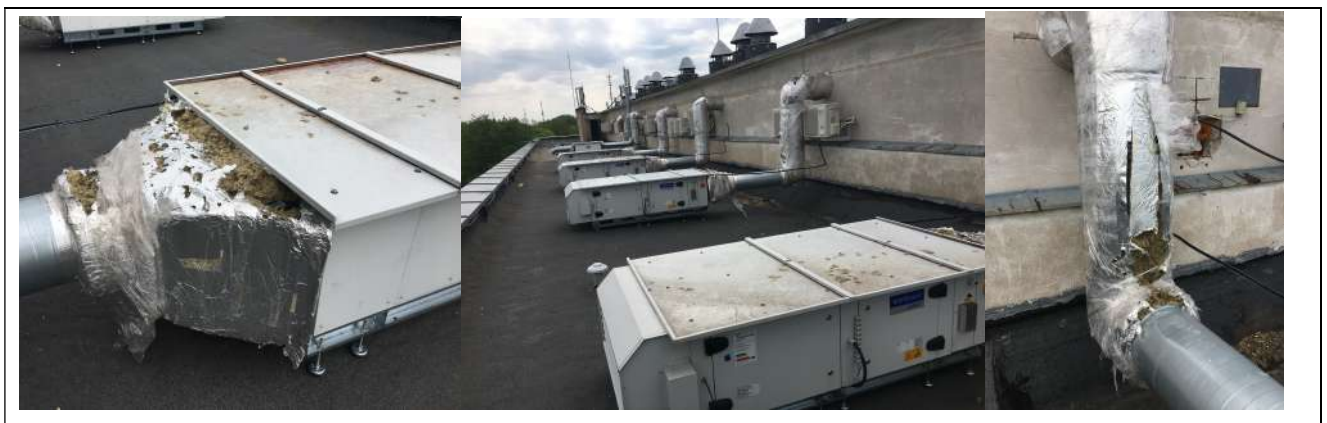
2 pav. vėdinimo elementų esamos būklės foto fikscija
