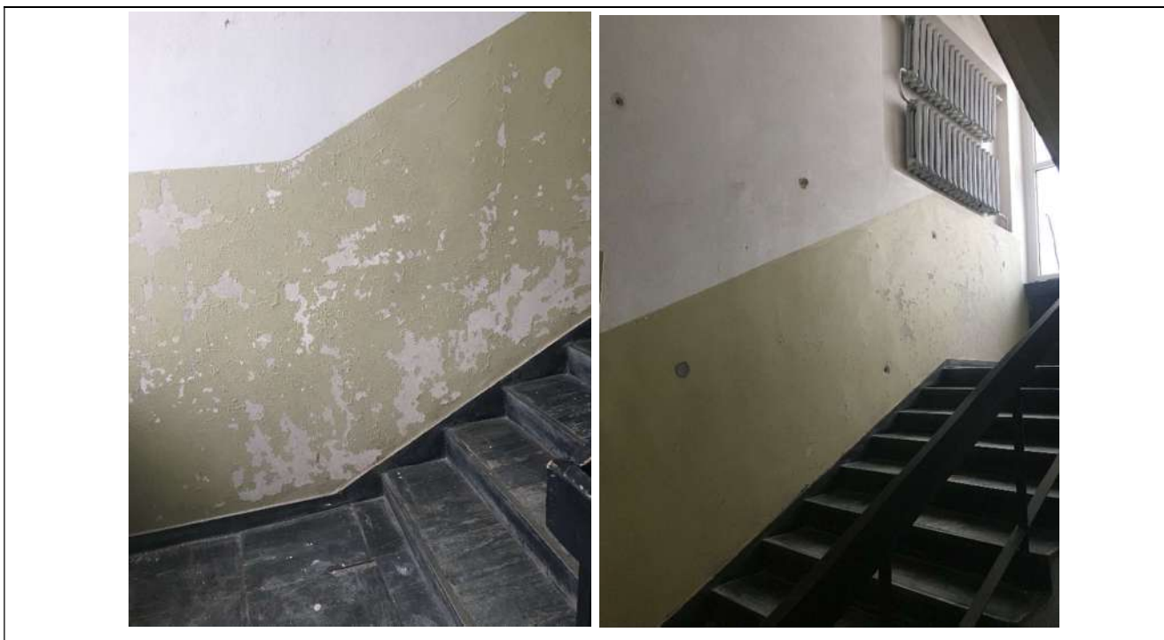
2 pav. laiptinės sienų esamos būklės foto fiksacija
