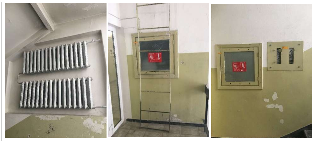
3 pav. laiptinės metalinių ir medinių elementų esamos būklės foto fikscija
