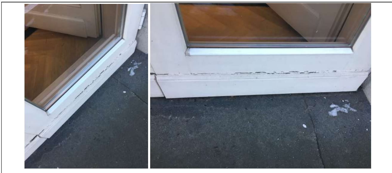
1 pav. balkono durų esamos būklės foto fikšacija
