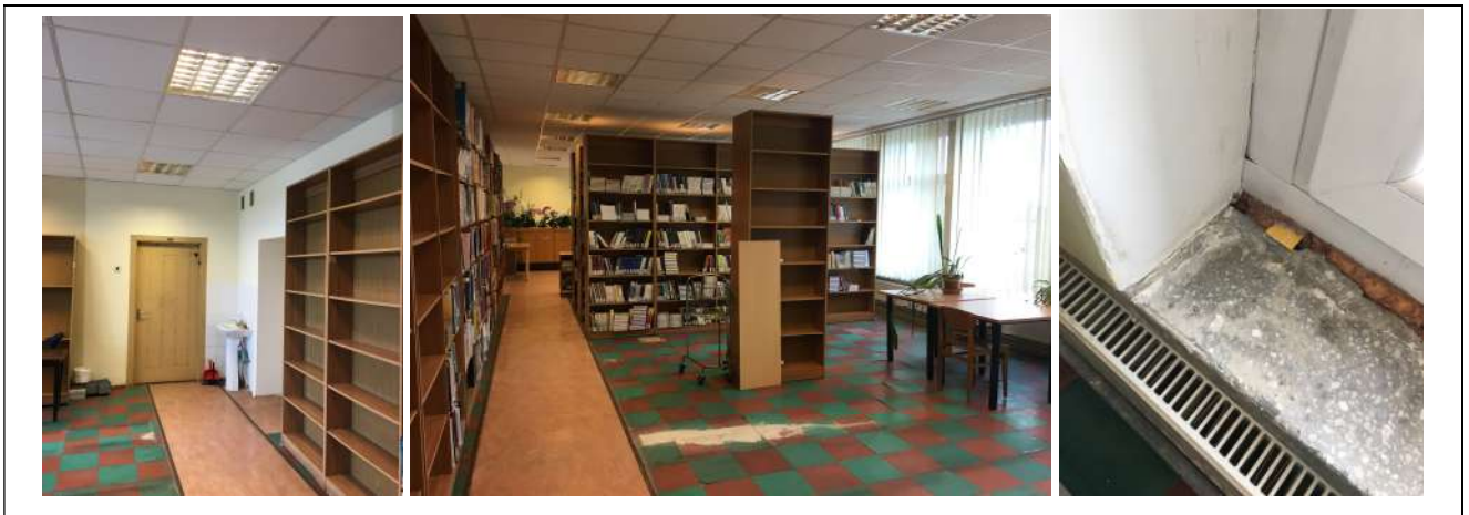
1 pav. patalpa 4-48 esamos būklės fotofiksacijos
