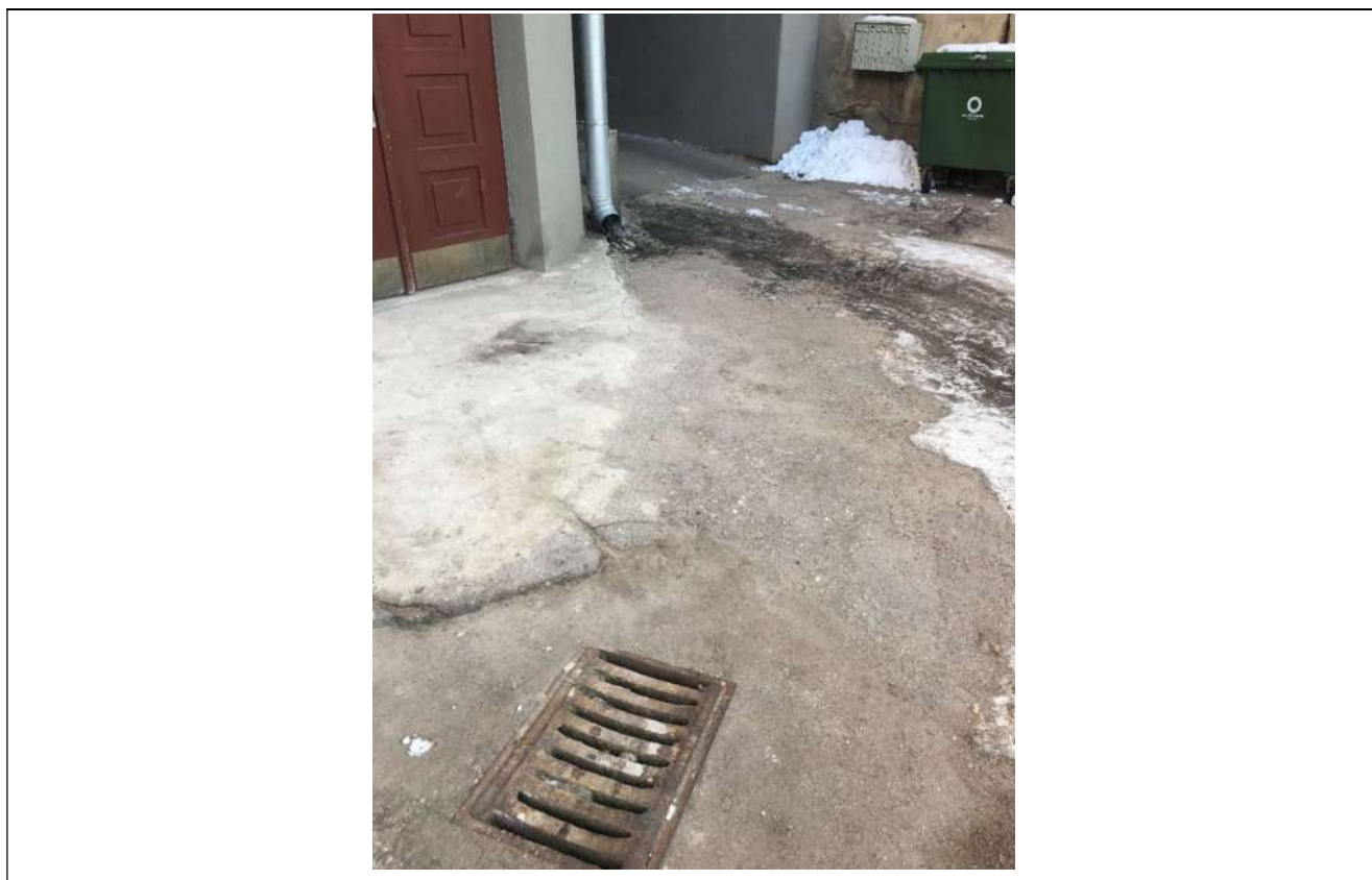
3 pav. lietvamzdžio ir šulinėlio esamos būklės foto fikscija
