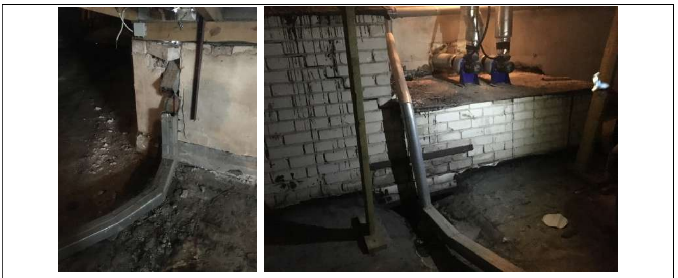
3 pav. lietaus surinkimo latakų esamos būklės fotografacijos
