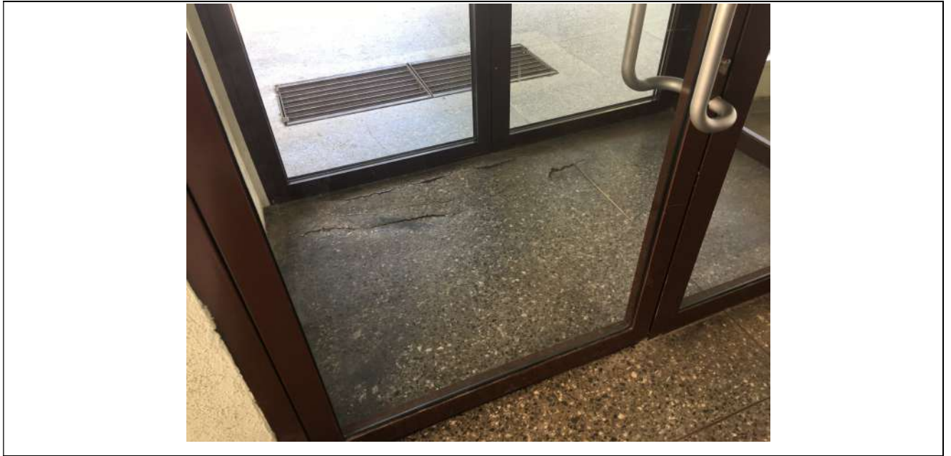
1 pav. pagrindinio įėjimo tambūro esamos būklės foto fiksacija
