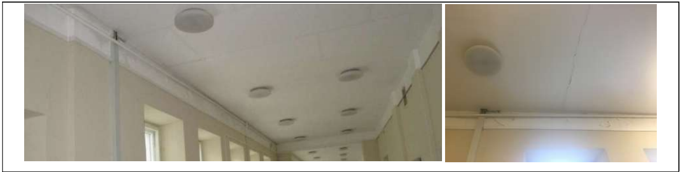
1 pav. II aukšto lubų esamos būklės foto fikscija
