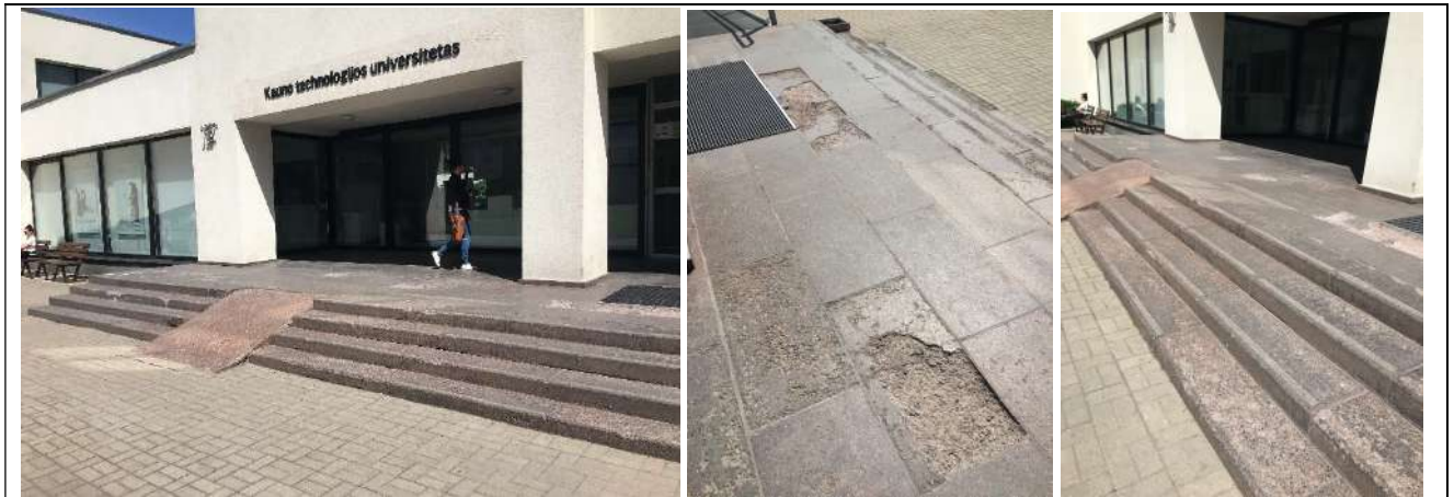
1 pav. pagrindinių įėjimo laiptų pakopų ir aikštelės esamos būklės foto fikscija
