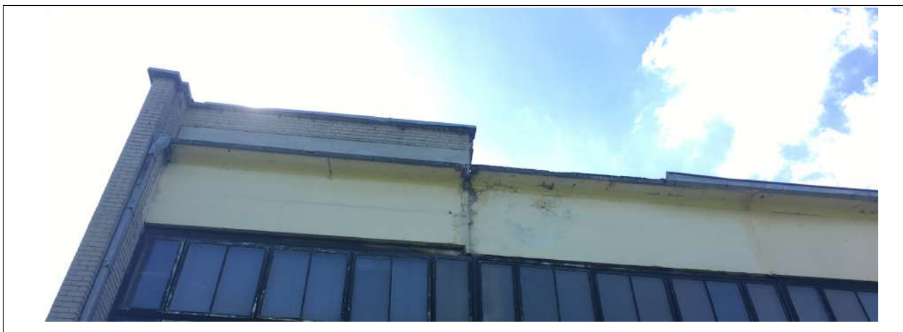
1 pav. latakų esamos būklės foto fikacija
