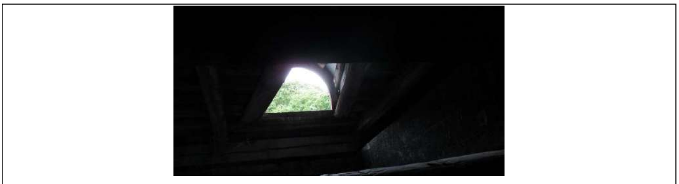
2 pav. palėpėje stoglangio esamos būklės foto fikscija
