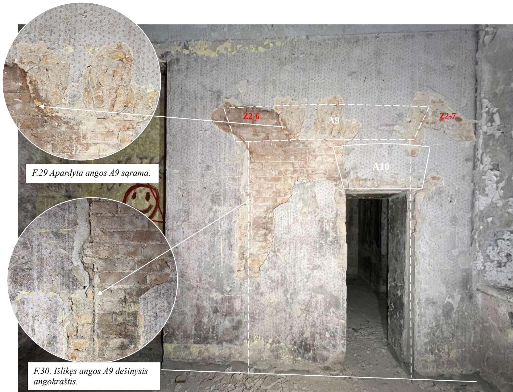
F.28. Tyrimų vieta Nr. 7. II aukštas. Sieną ašyje 2/C-D. Patalpa Nr.5. Zondai Z2-6, Z2-7.
