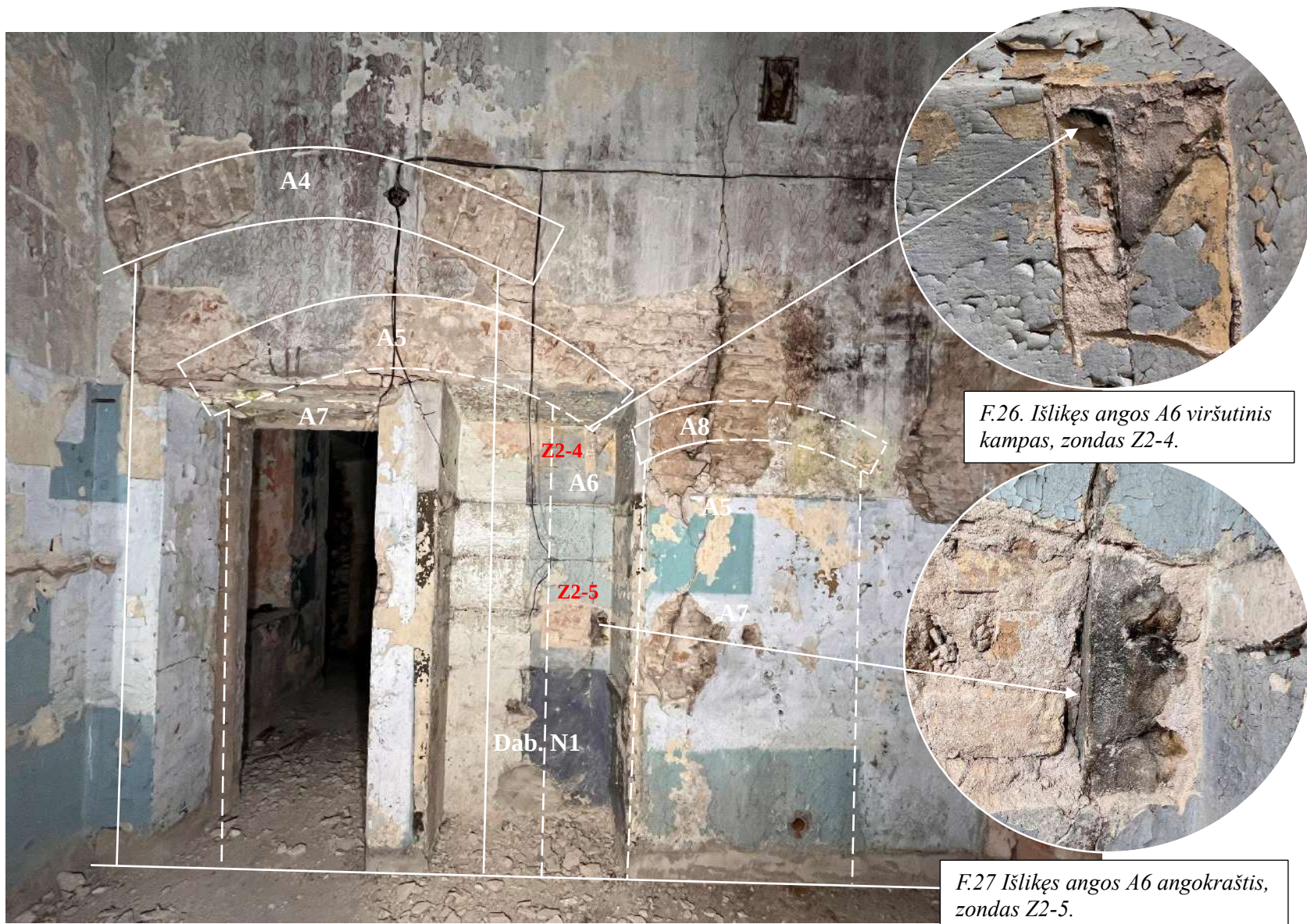
F. 25. Tyrimų vieta Nr. 6. II aukštas. Sieną ašyje 3/D-C. Patalpa Nr.5, At2-2, Z2-4, Z2-5.
