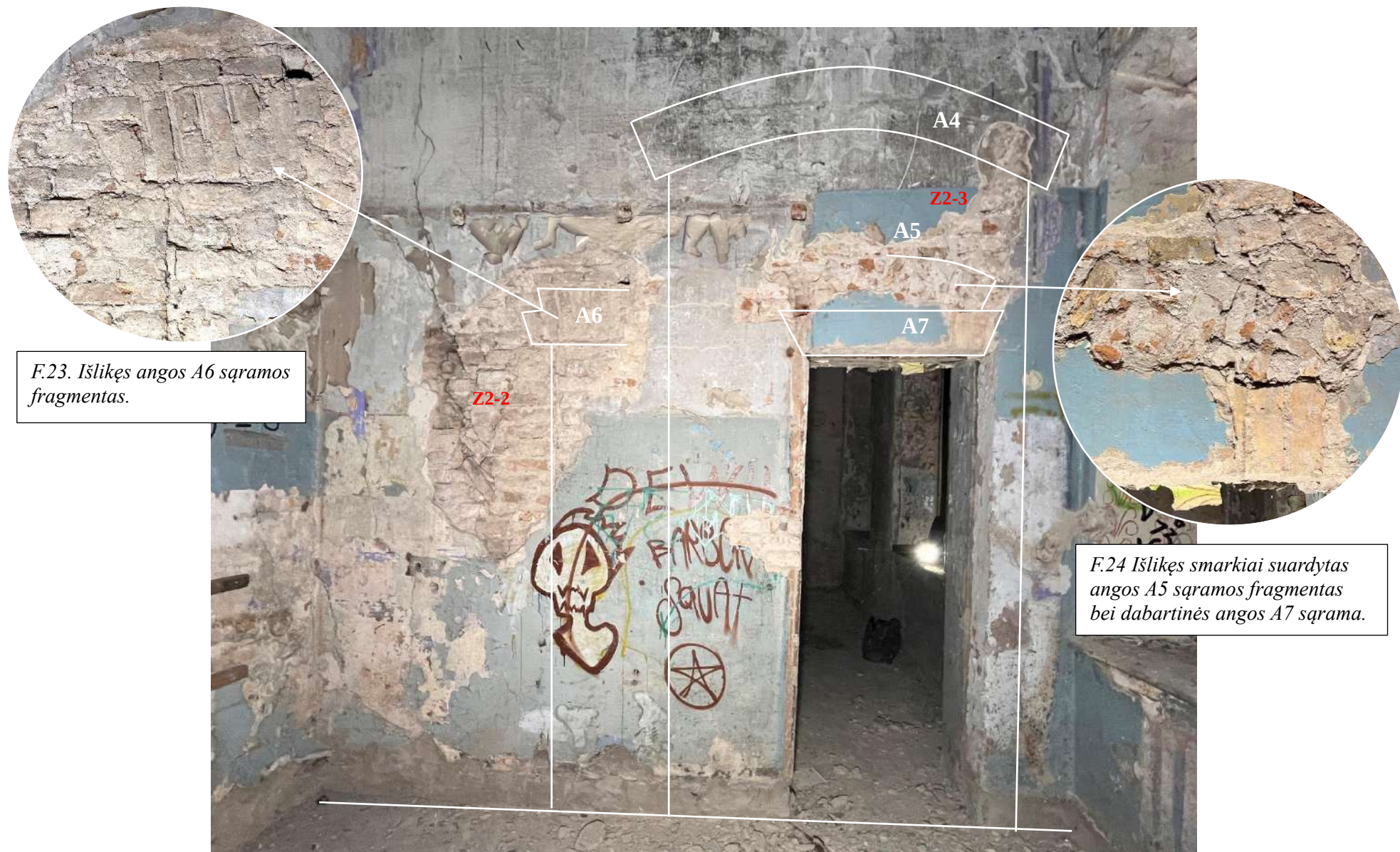
F.22. Tyrimų vieta Nr. 6. II aukštas. Sieną ašyje 3/C-D. Patalpa Nr.6, zondai Z2-2, Z2-3.
