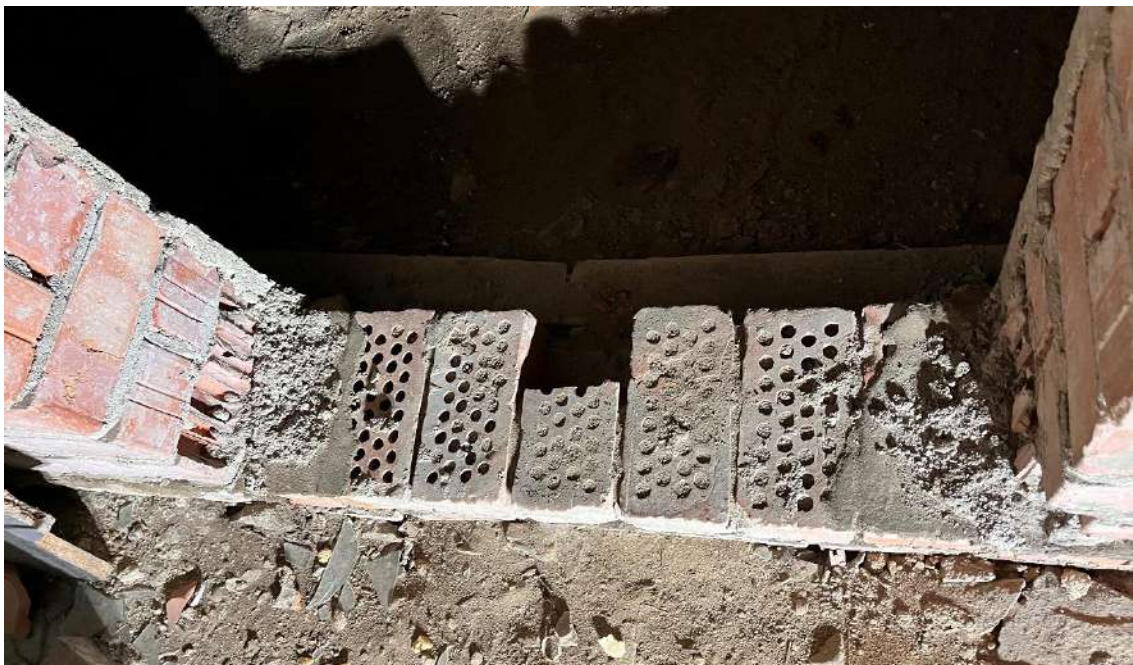
F.3. Durų angos slektis formuotas iš kiaurymėtu plytų.
