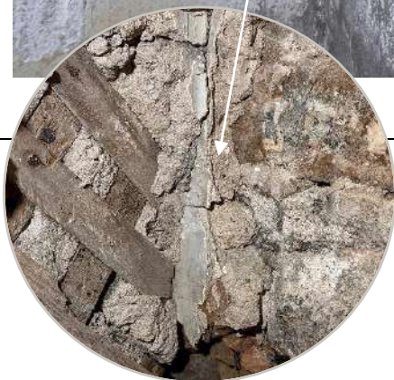
F.15. Tarp balanų sienos ir mūro „A“ matomi dažų ir tinko fragmentai, besitęsiantys gilyn.
