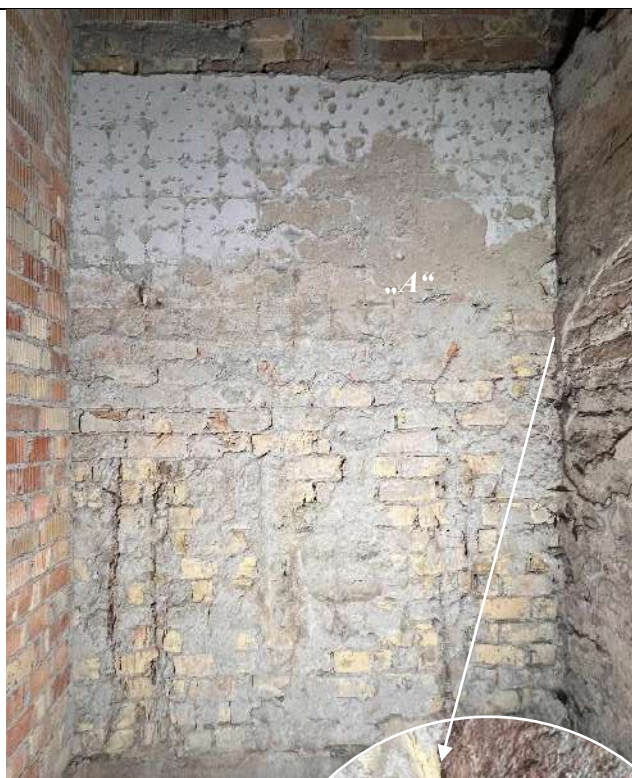
F.9 Patalpa Nr. 8a.
