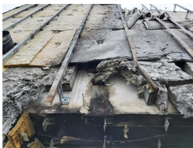
101 pav. Pastato pietvakarių kampo bendrasis vaizdas ir fasado sluoksnių pažeidimo vaizdas virš sudegusiųjų vartų
