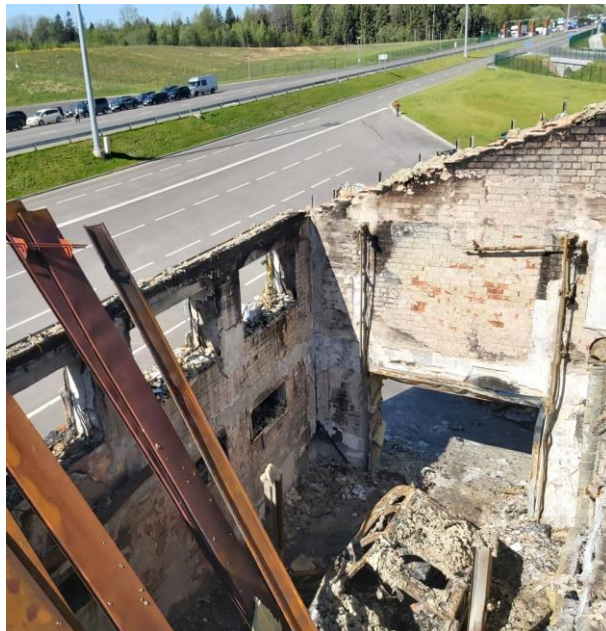
35 pav. Sudegusios stogo laikančiosios konstrukcijos, sugadinta auto angaro patalpa
