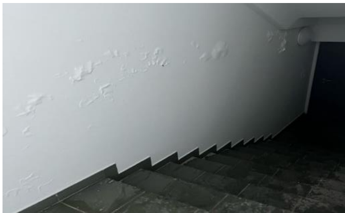
97 pav. Laiptinės patalpos sienos vaizdas: dėl drėgmės yra nusilupę sienos dažai
