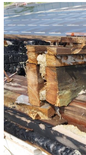
60 pav. Stogo medinių gegnių sudėtingojo skerspjūvio matavimas: medinių lentų storis – 60 mm, tarpas tarp lentų – 50 mm
