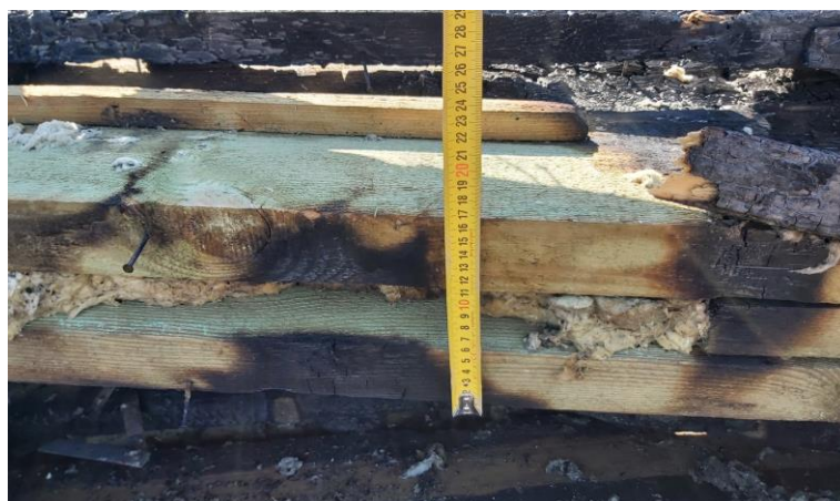
62 pav. Stogo medinių gegnių sudėtingojo skerspjūvio matavimas: medinių lentų storis – 60 mm, tarpas tarp lentų – 50 mm
