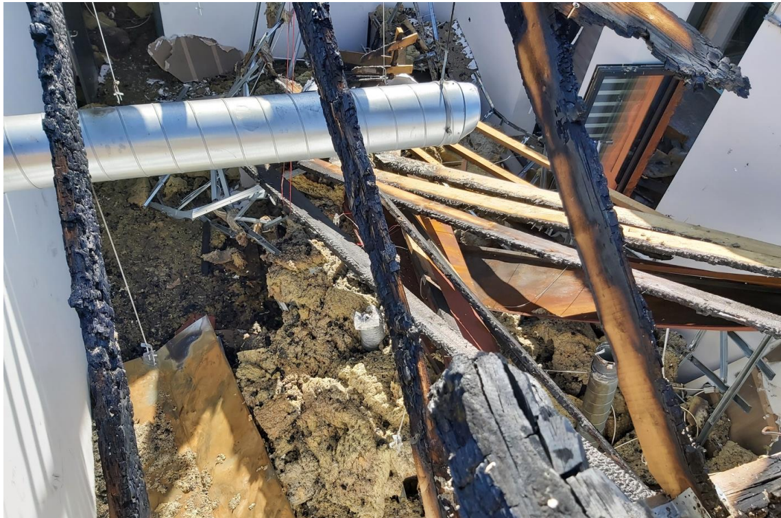
36 pav. Sudegusios stogo laikančiosios konstrukcijos koridoriaus viduje
