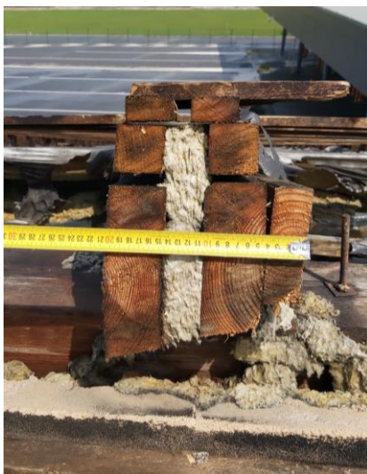
60 pav. Stogo medinių gegnių sudėtingojo skerspjūvio matavimas: medinių lentų storis – 60 mm, tarpas tarp lentų – 50 mm
