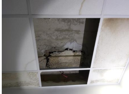
87 pav. Betono stiprio tikrinimo vietos ant perdangos vaizdas pirmajame aukšte
