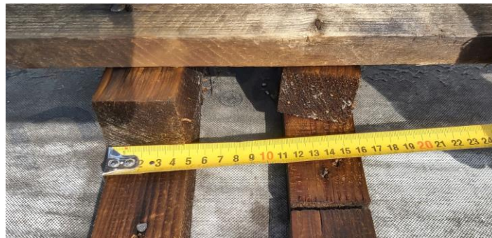
59 pav. Ant gegnės uždėtų medinių juostų-tašų (virš izoliacinio audinio) 50 mm pločio ir 60 mm tarpo matavimas
