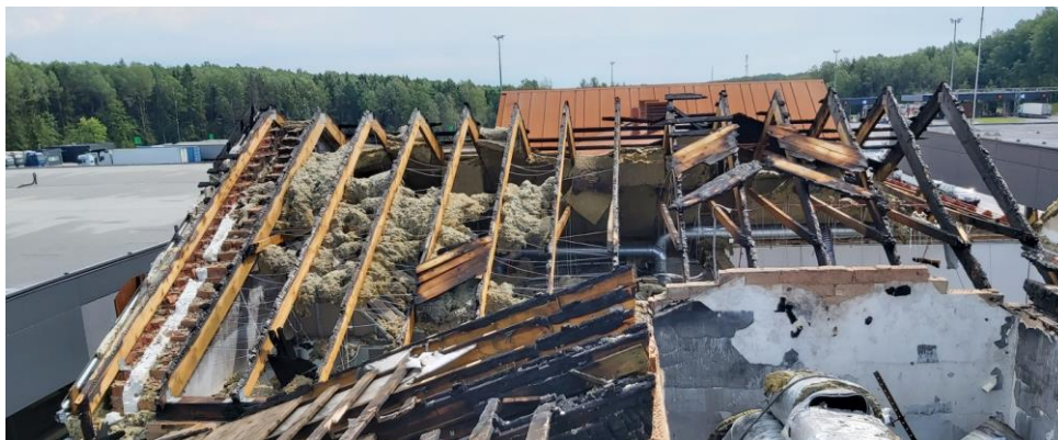
39 pav. Sudegusiojo stogo konstrukcijų tarp ašių „2“–„3“ bendrasis vaizdas
