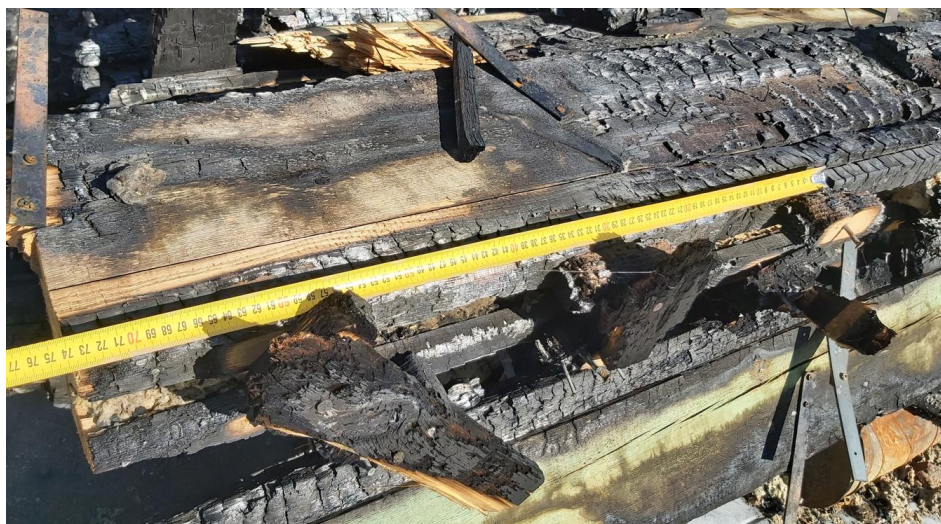
61 pav. Medinių grebėstų tvirtinimo 30 cm žingsnio matavimas
