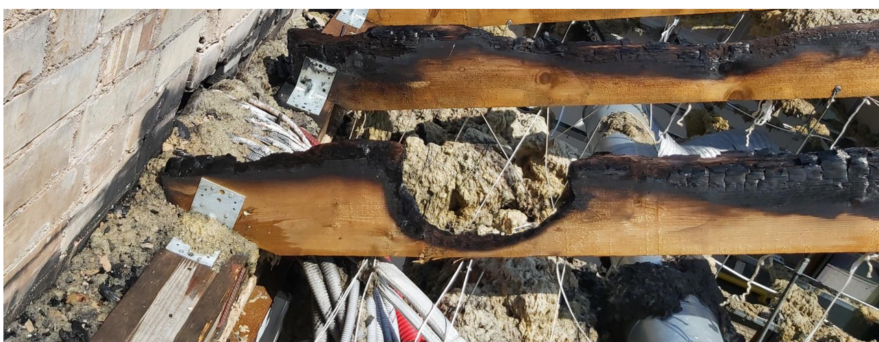
91 pav. Medinių gegnių skerspjūviai kritiškai sumažėjo, sudegė
