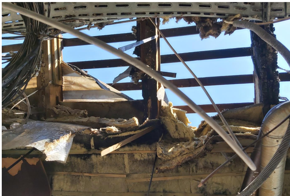
49 pav. Koridoriaus tarp ašių nuo „1“ iki „2“ ir nuo „C“ iki „D“ sugadinto stogo fragmento vaizdas – dangos sluoksniai ir inžineriniai tinklai gaisro metu buvo sugadinti, griuvo
