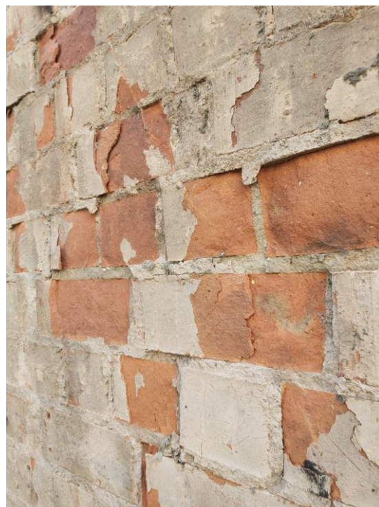
95 pav. Angaro mūro sienos ašyje „F“ ir tarp ašių nuo „1“ iki „2“ gaisro paveikto ruožo plytų paviršiaus išsisluoksniavimas, tinko nutrupėjimas – fragmentų vaizdai
