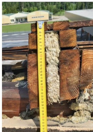
60 pav. Stogo medinių gegnių sudėtingojo skerspjūvio matavimas: medinių lentų storis – 60 mm, tarpas tarp lentų – 50 mm
