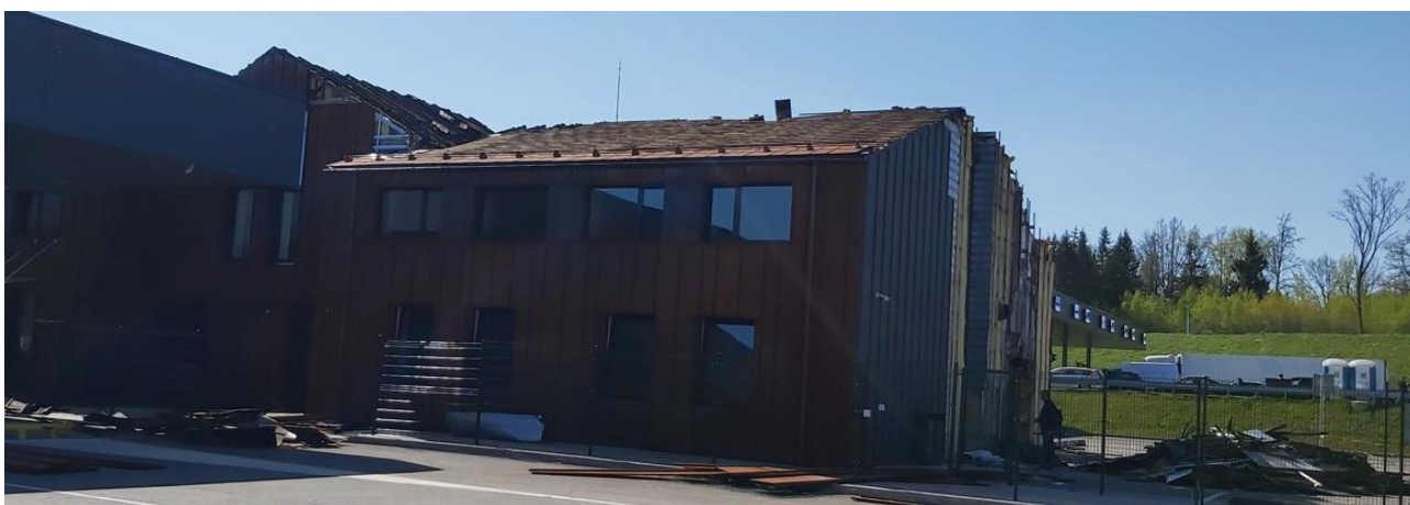
4 pav. Pastato bendrasis vaizdas nuo šiaurės pusės, 2024 m. gegužės 2 d.
