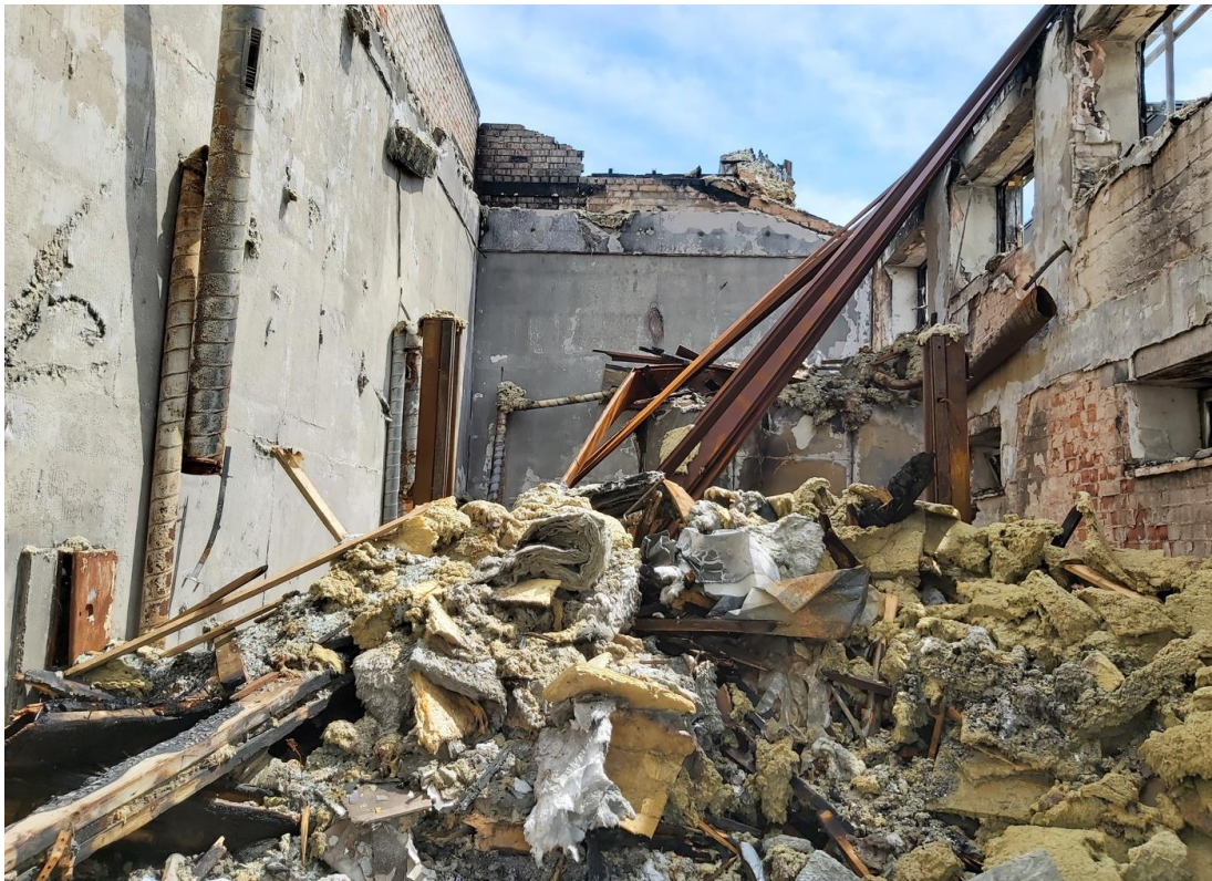
31 pav. Sugadinta angaro patalpa tarp ašių nuo „1“ iki „2“ ir nuo „D“ iki „F“ (per du aukštus)
