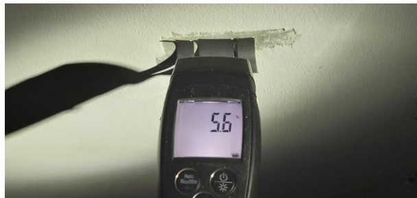
75 pav. Rūšio patalpos tarp ašių „1“–„2“ ir „A“–„B“ gelžbetoninės perdangos plokštės drėgmės lygio matavimas: 5,6 %
