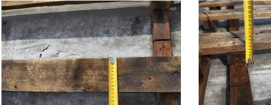
58 pav. Medinių grebėstų 97 mm pločio ir 20 mm storio matavimas, medinio trumpinio 45 mm aukščio matavimas
