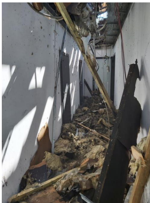
48 pav. Koridoriaus tarp ašių nuo „1“ iki „2“ ir nuo „C“ iki „D“ stogo inžineriniai tinklai gaisro metu buvo sugadinti, griuvo
