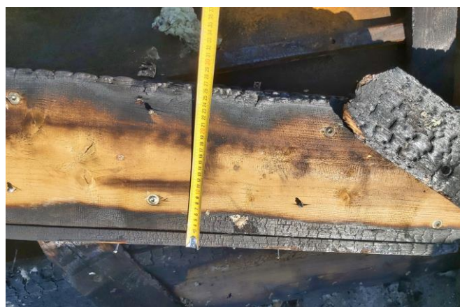
63 pav. Apdegusios medinės gegnės skerspjūvio matavimas: 25 mm medinė juosta ir apie 250 mm medinės gegnės lentos aukštis
