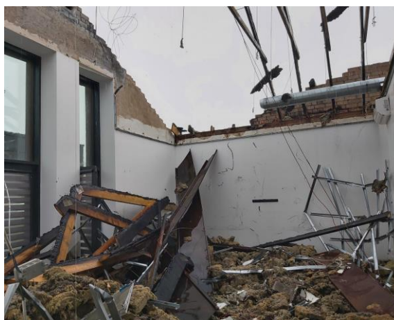
103 pav. Nebesandarus ir dalinai įgriuvęs stogas, užpildtos patalpos, sunaikinta ir sugadinta inžinerinių sistemų įranga, inžineriniai tinklai
