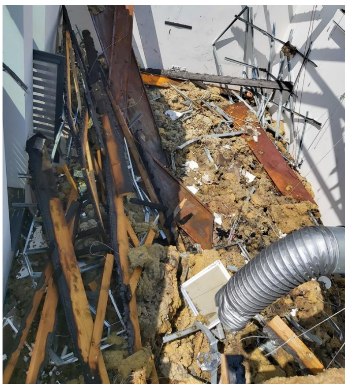
45 pav. Gaisro metu stogo laikančiosios konstrukcijos ir visi stogo dangos sluoksniai griuvo į patalpas, kuriose kurį laiką dar degdavo
