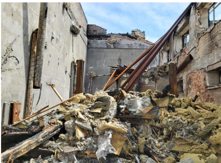
100 pav. Sugadintos, nukritusios stogo atitvarinės konstrukcijos
