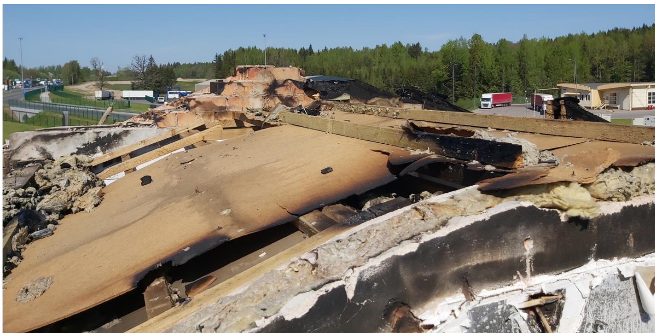
46 pav. Stogo dalinai apdegusio fragmento tarp ašių nuo „1“ iki „2“ ir nuo „A“ iki „C“ prie kraigo bendrasis vaizdas
