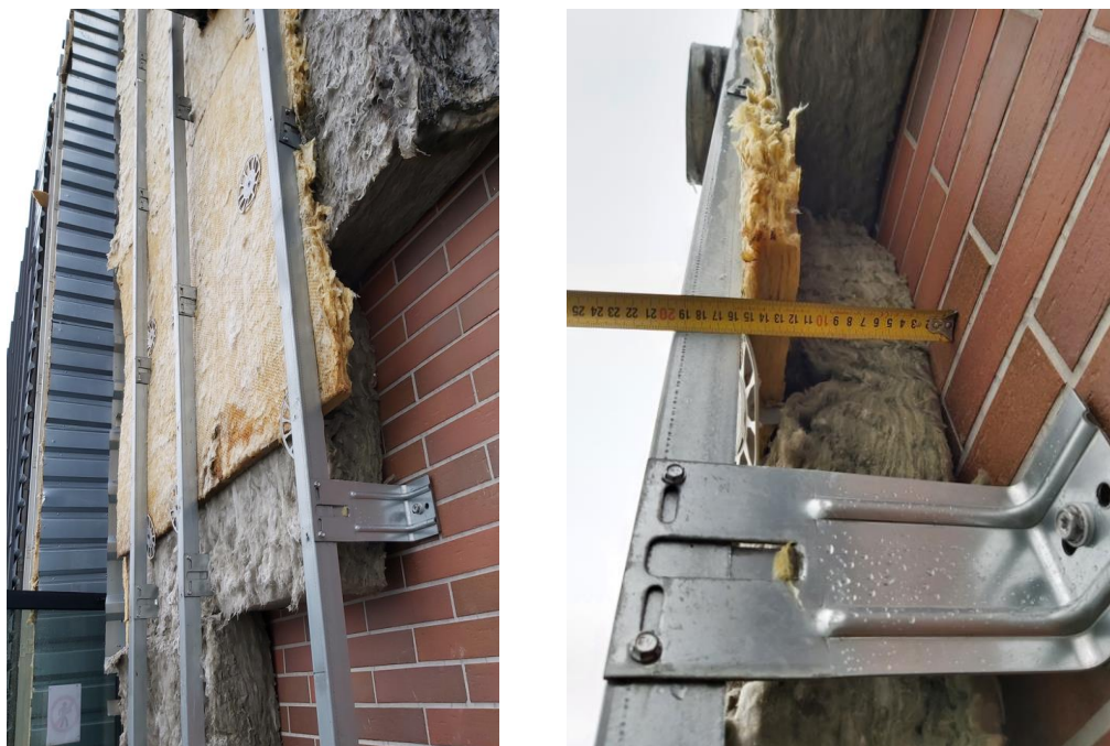
66 pav. Fasado sienos apmatavimas: prie anksčiau pastatytos sienos su plytų imitacijos apdaila pritvirtintas fasadą laikantis metalinių kreipiančiųjų ir metalinių tvirtinimo detalių karkasas; išmatuotas šiluminės vatos pagrindinis sluoksnis – 120 mm; išmatuotas mineralinės vatos viršutinis sluoksnis – 30 mm; metalinio karkaso lauko plokštumos atitraukimo matmuo – 200 mm
