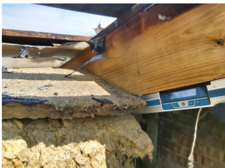
57 pav. Stogo gegnių nuolydžio tikrinimas tarp ašių „3“–„4“ ir „C“–„D“: 18,4 laipsnių (projekte nurodytas 20 laipsnių nuolydis)
