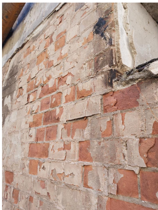
95 pav. Angaro mūro sienos ašyje „F“ ir tarp ašių nuo „1“ iki „2“ gaisro paveikto ruožo plytų paviršiaus išsisluoksniavimas, tinko nutrupėjimas – fragmentų vaizdai
