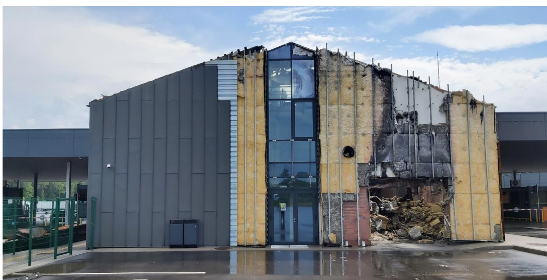
30 pav. Suniokotas pastato vakarų fasadas – pažeista apdaila ir vartai
