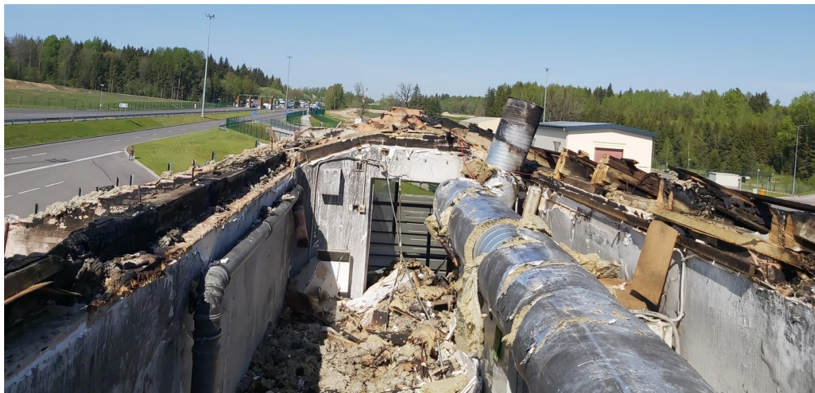
44 pav. Sudegusiojo stogo tarp ašių nuo „1“ iki „2“ ir nuo „C“ iki „D“ bendrasis vaizdas, žiūrint į vakarus
