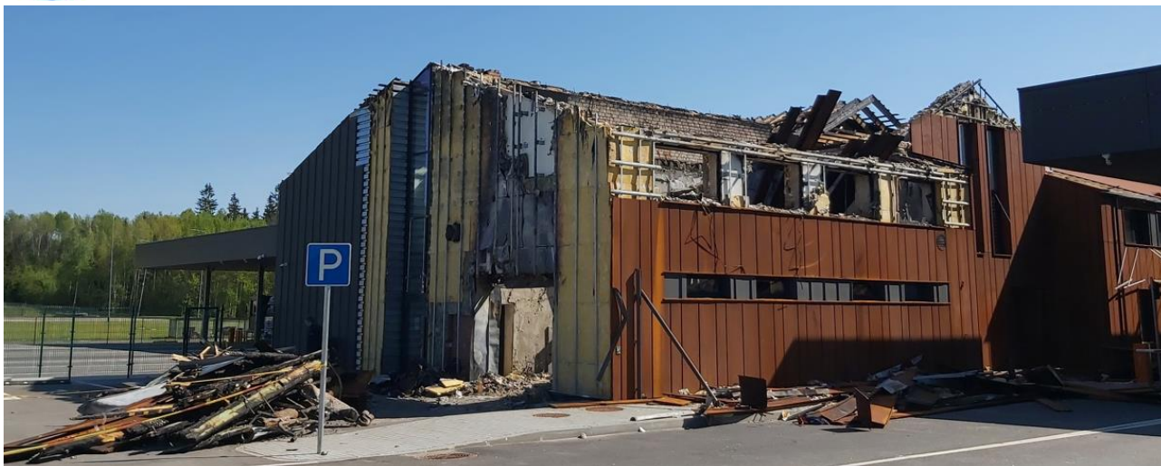
2 pav. Pastato bendrasis vaizdas iš pietvakarių pusės, 2024 m. gegužės 2 d.
