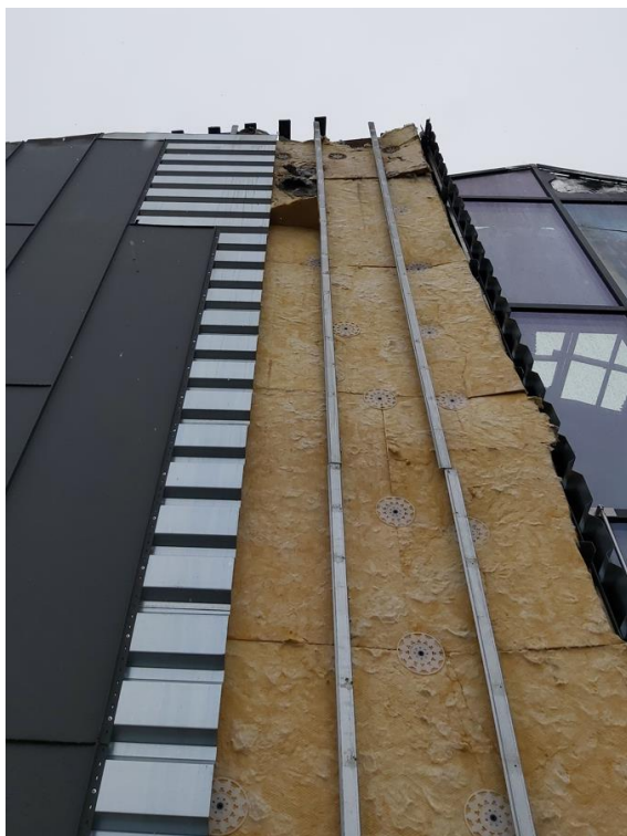
64 pav. Dalinai pažeistų sienos detalių sluoksnių bendrieji vaizdai
