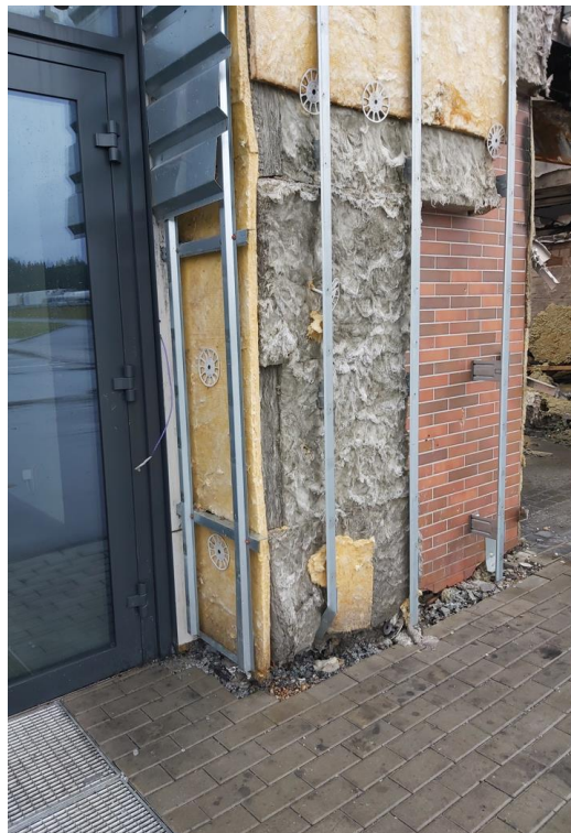
64 pav. Dalinai pažeistų sienos detalių sluoksnių bendrieji vaizdai
