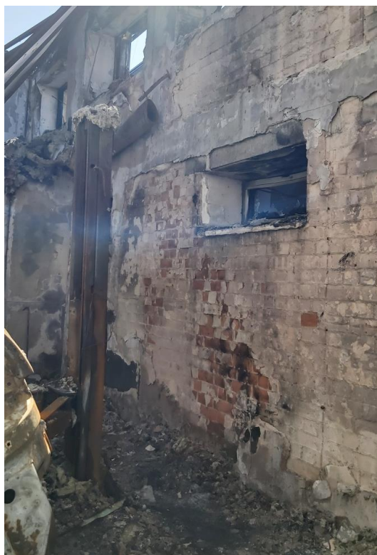
94 pav. Angaro mūro sienos ašyje „F“ ir tarp ašių nuo „1“ iki „2“ gaisro paveikto ruožo plytų paviršiaus išsisluoksniavimas, tinko nutrupėjimas
