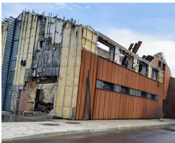
101 pav. Pastato pietvakarių kampo bendrasis vaizdas ir fasado sluoksnių pažeidimo vaizdas virš sudegusiųjų vartų
