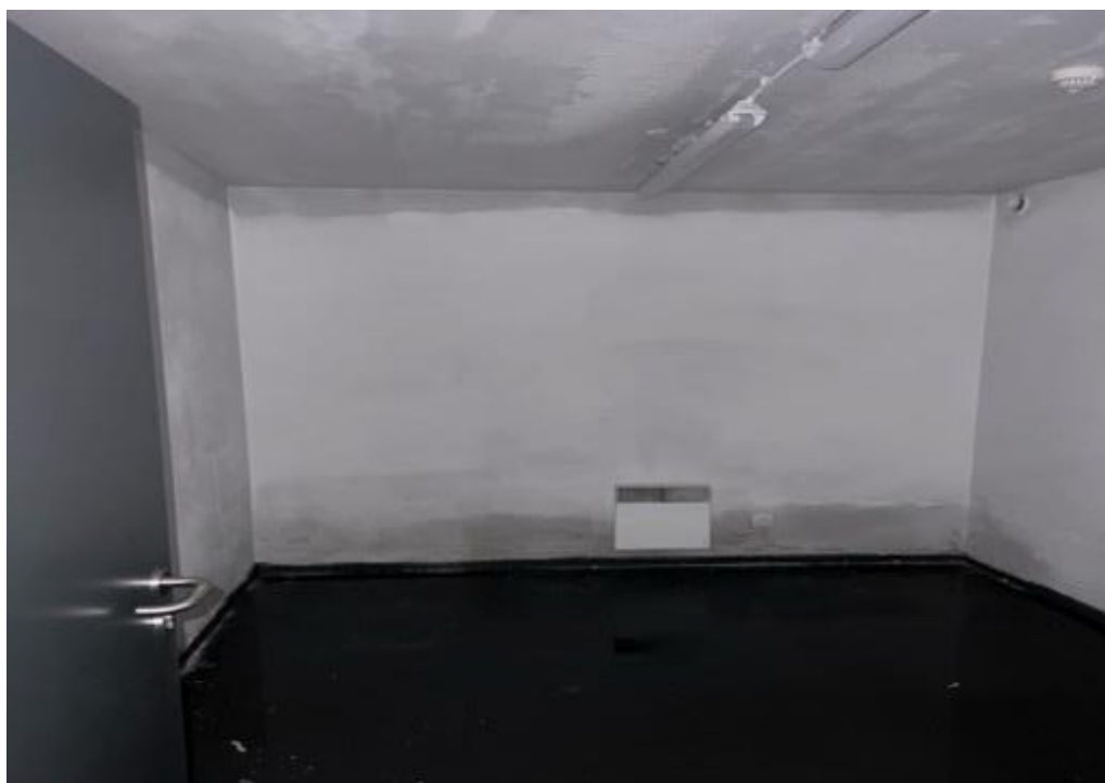
96 pav. Užpiltos rūsio patalpos bendrasis vaizdas: drėgnas grindų paviršius, perdangos paviršius, dalinai – sienų ruožai viršuje ir apačioje
