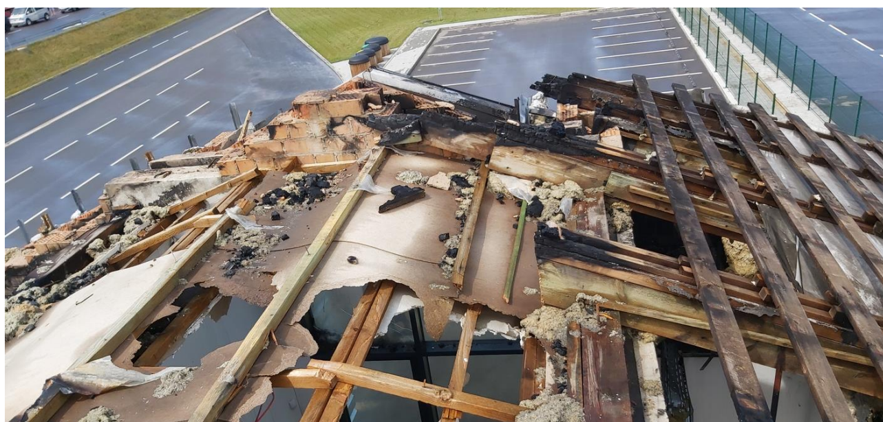
38 pav. Sudegusiojo stogo vakarinio krašto prie ašies „1“ konstrukcijų bendrasis vaizdas
