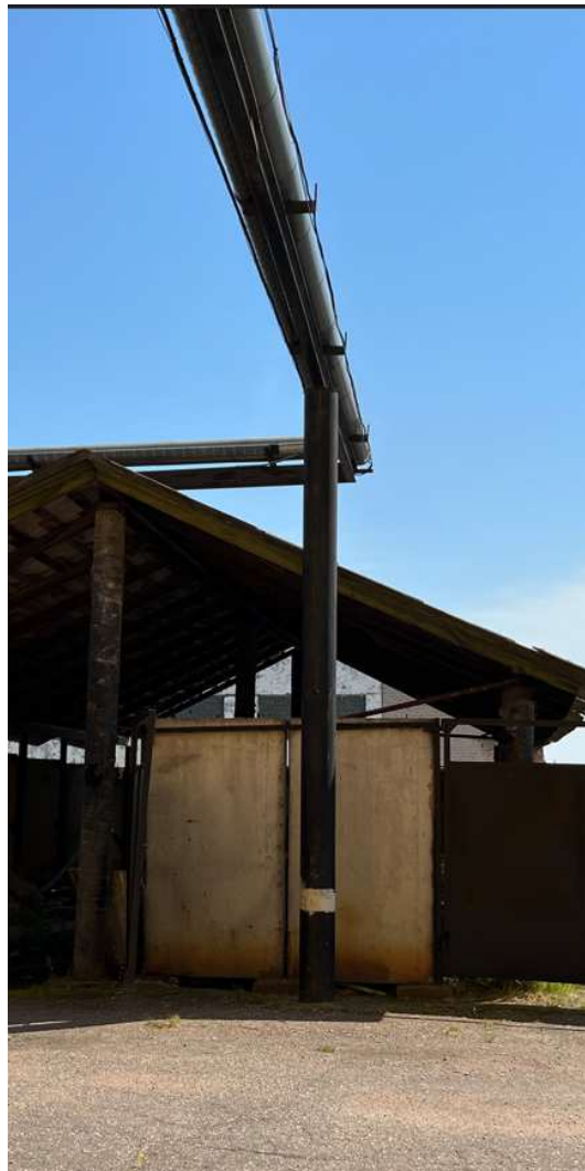
1 pav. Esamos estakados konstrukcijos.
