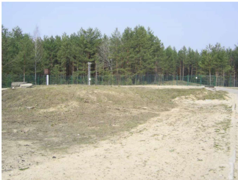
2-7 pav. Skystųjų radioaktyviųjų atliekų rezervuaro vaizdas: kairėje – pagrindinė anga patekti į rezervuarą, dešinėje – speciali anga skystųjų atliekų supylimui [7]
