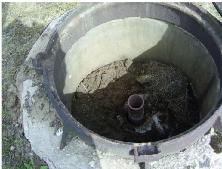
2-8 pav. Skystųjų radioaktyviųjų atliekų rezervuaro specialioji anga skirta pilti radioaktyviosioms atliekoms [7]
