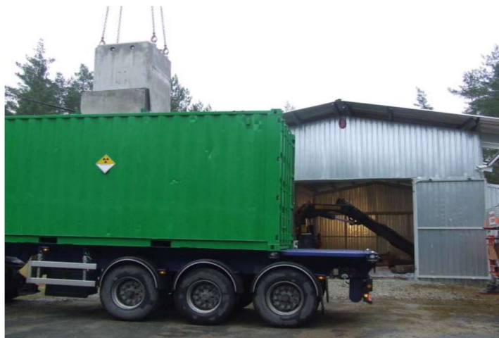
8-17 pav. Gelžbetoninio konteinerio C30/37 pakrauto talpomis su PUŠ pakrovimas į transportavimo konteinerį (Tammiku RAS, Estija)
