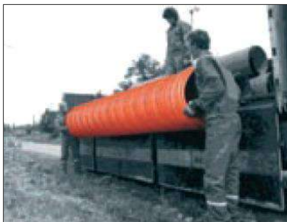
3 pav. Vamzdžių krovos darbai
