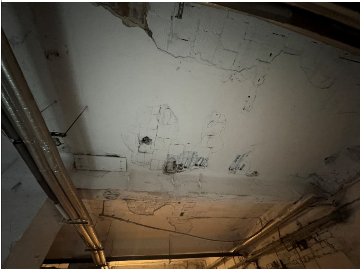
Surenkamos keraminių blokelių perdangos bendras vaizdas
