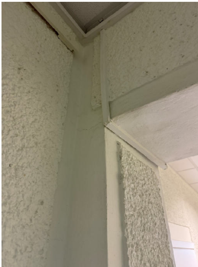
Antro aukšto koridoriuje fiksuojami horizontalūs įtrūkiai ties kolona (Patalpa 2-36)
