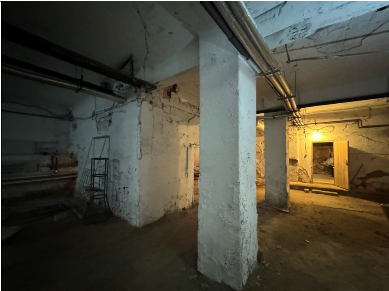
Bendras pusrūsio patalpų vaizdas (neremontuota dalis)
