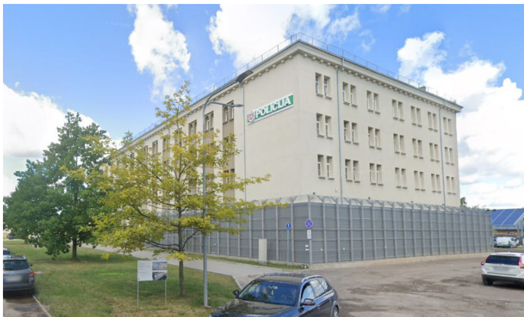
2 pav. Remontuojamo pastato fotofiksacija
