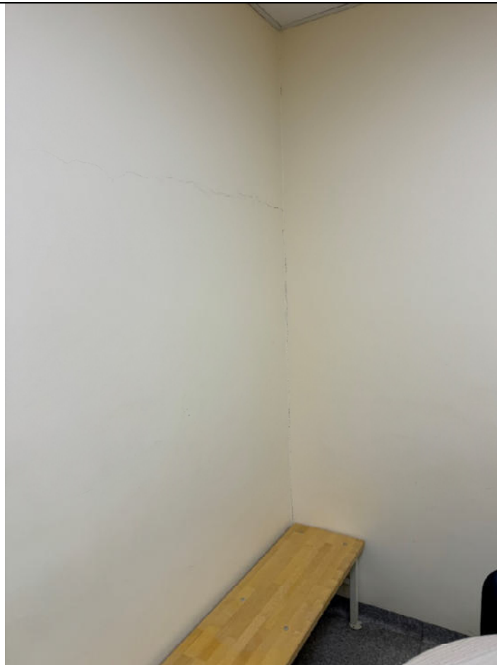
Pirmo aukšto patalpose sienose fiksuojami horizontalūs įtrūkiai (Patalpa 1-51)
