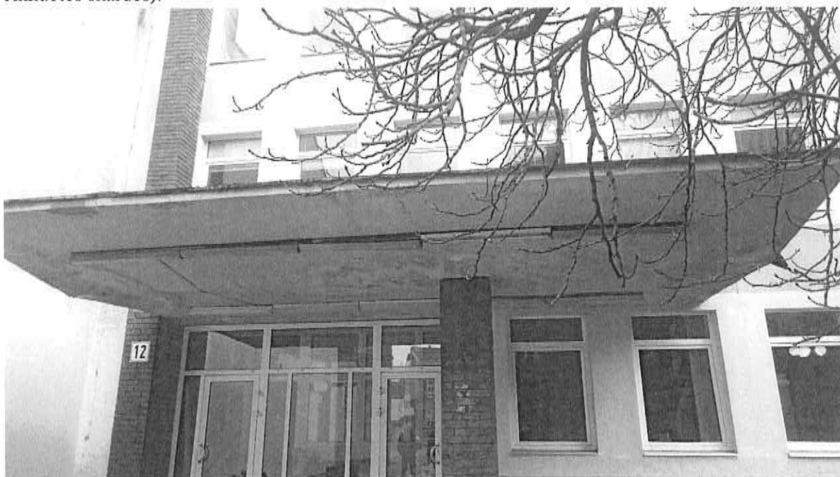
4 pav. Stogelis virš įėjimo, kurį reikia suremontuoti
