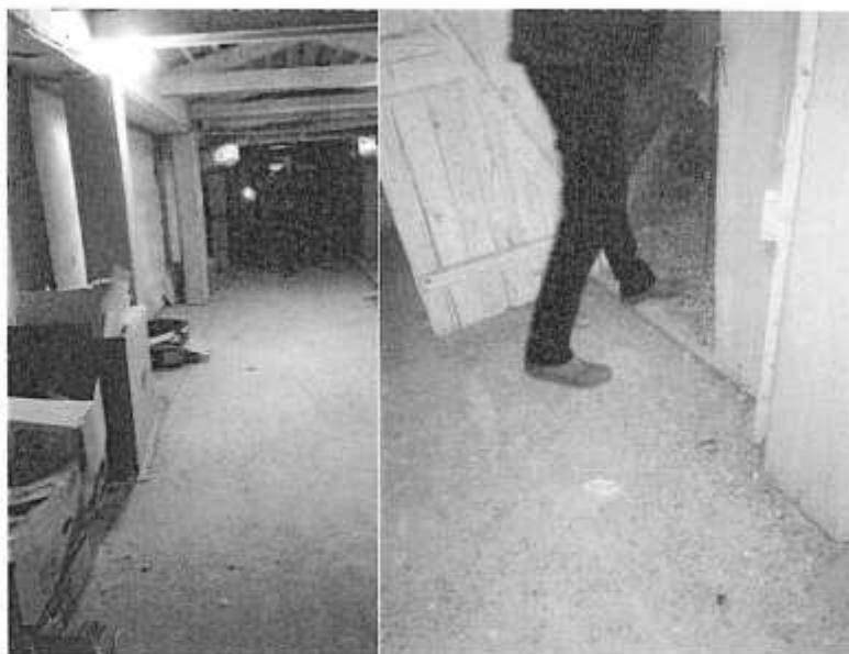
9 pav. Pastato palėpės patalpų esamos būklės fotofiksacija
