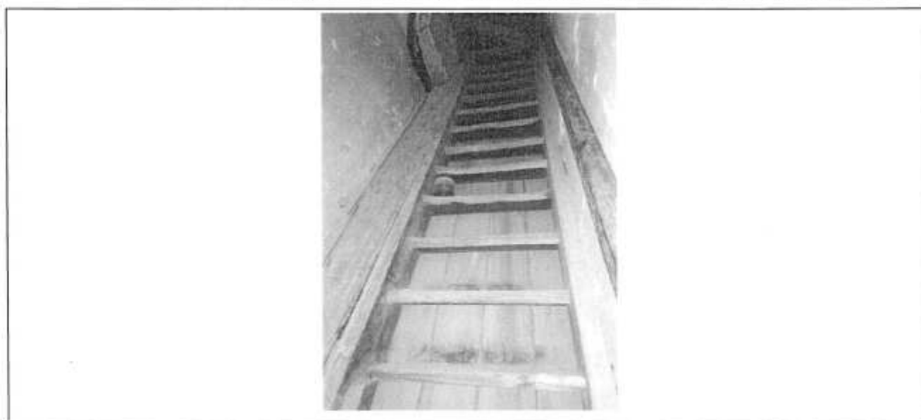
7 pav. Palėpės laiptinės esamos būklės fotofiksacija
